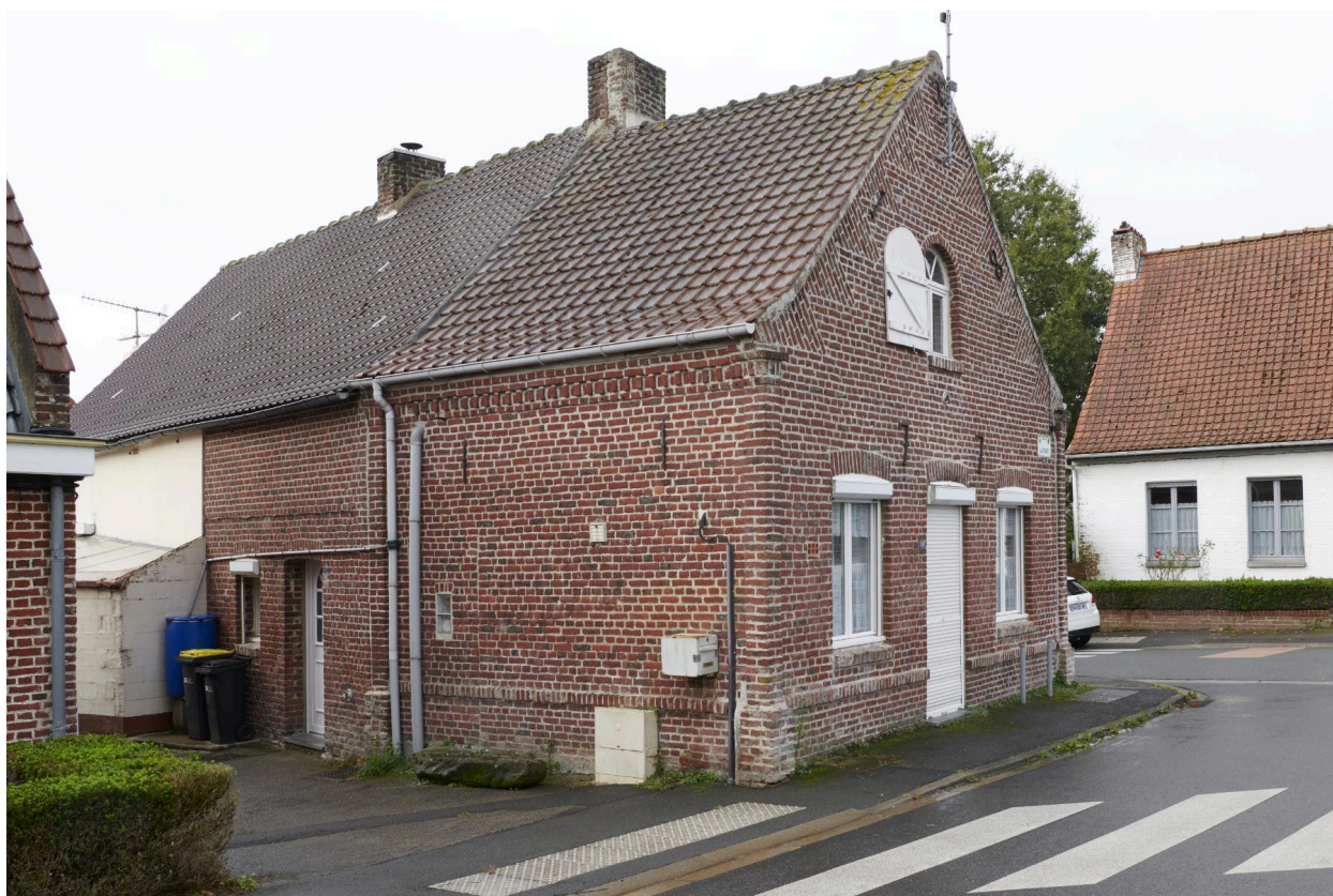
Vue depuis le nord-est.
