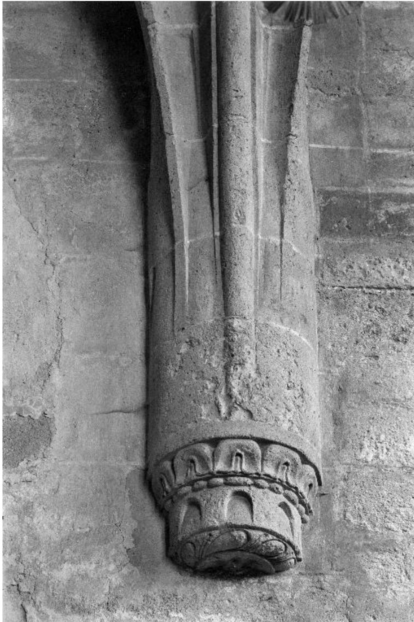
Détail d'un culot du mur nord du chœur, supportant la retombée des arcs de la voûte.
