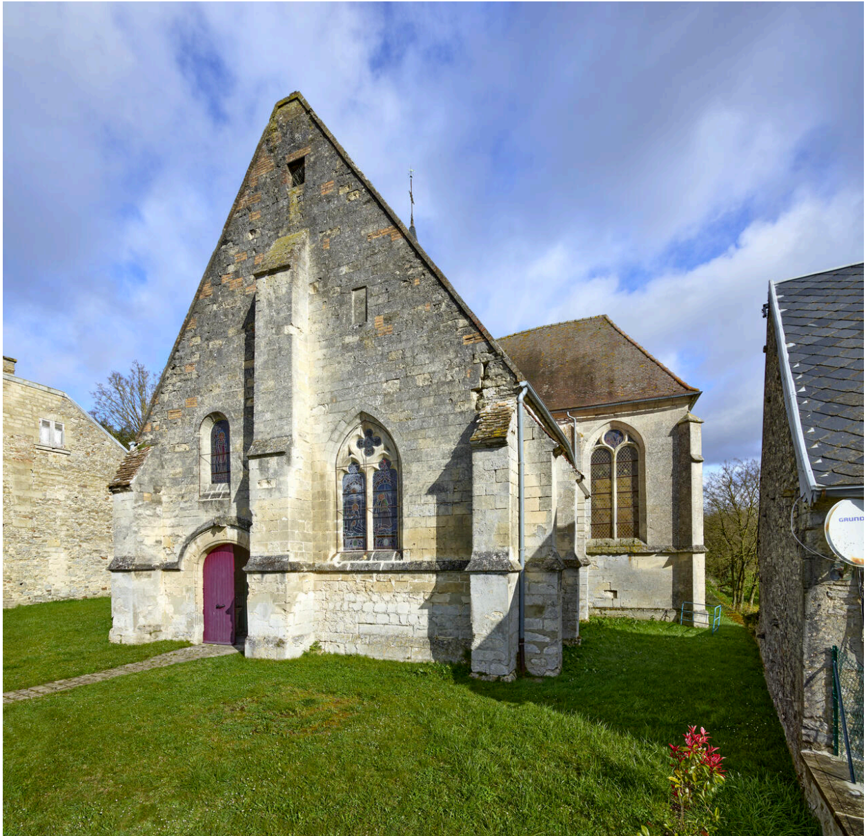
Vue de l'entrée par le transept et de la travée du chœur.
