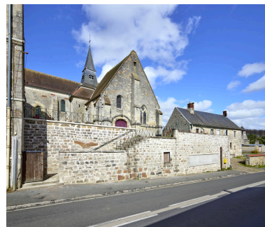
Vue générale depuis la rue au sud. Phot. Thierry Lefébure IVR32_20240200314NUCA
