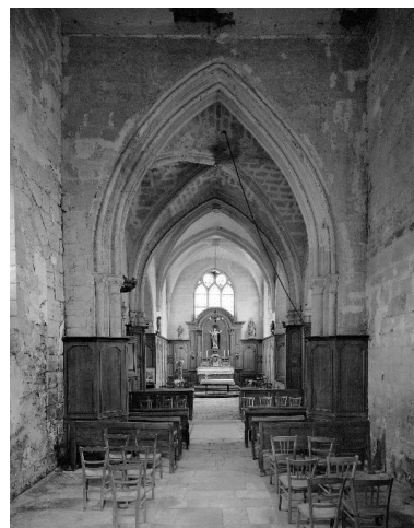
Vue intérieure de l'édifice, depuis l'entrée vers le chœur. Phot. Fabrice Charrondière IVR22_19860200348V
