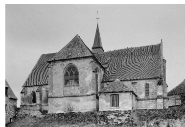
Vue générale du chevet, de la sacristie et de l'élévation orientale du transept. Phot. Fabrice Charrondièrre IVR22_19860200323X
