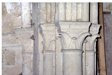
Vue des chapiteaux des colonnes qui sont situées entre la nef et le transept. Phot. Christiane Riboulleau IVR22_19930200014ZA
