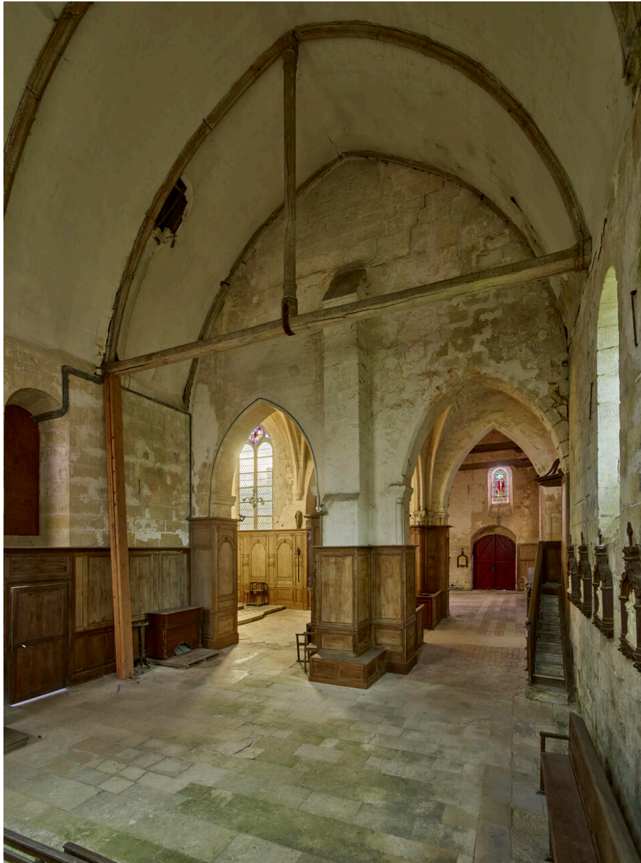
Vue de l'ensemble du transept depuis le nord.
