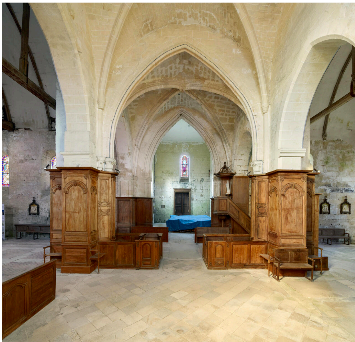
Vue de la croisée du transept vers l'entrée.
