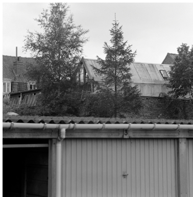
Atelier de fabrication, vue prise vers l'est. Phot. Philippe Dapvril IVR31_19885900898X
