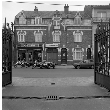
Élévation antérieure, rue Jean-Jaurès. Phot. Philippe Dapvril IVR31_19885900781X
