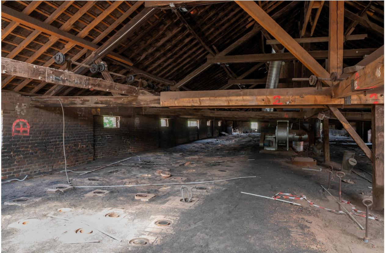
Couvrement du four Hoffmann. Au sol les trappes d'alimentation en poudre de charbon via des "marmites" (disparues). La marche du four était commandée par des transmissions fixées à la charpente.
