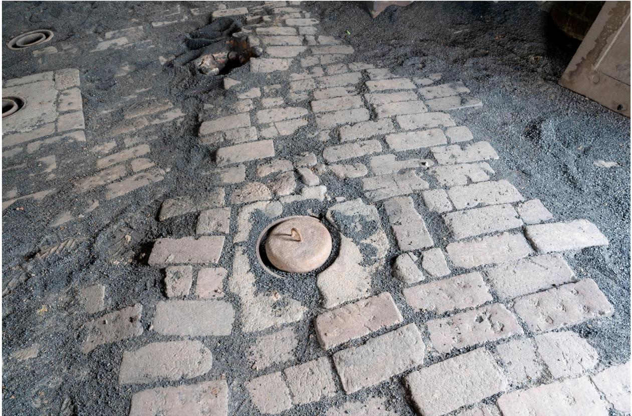
Couvrement du four Hoffmann. Au sol une trappe d'alimentation en poudre de charbon en position fermée.
