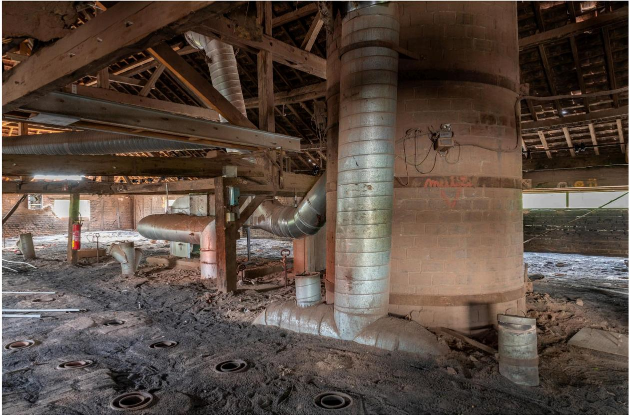
Couvrement du four Hoffmann. Cheminée d'évacuation des fumées et conduits de récupération d'air chaud pour le séchoir (étuve).
