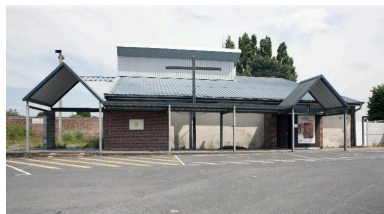
Élévation antérieure de l'église. Phot. Pierre Thibaut IVR31_20155900424NUCA
