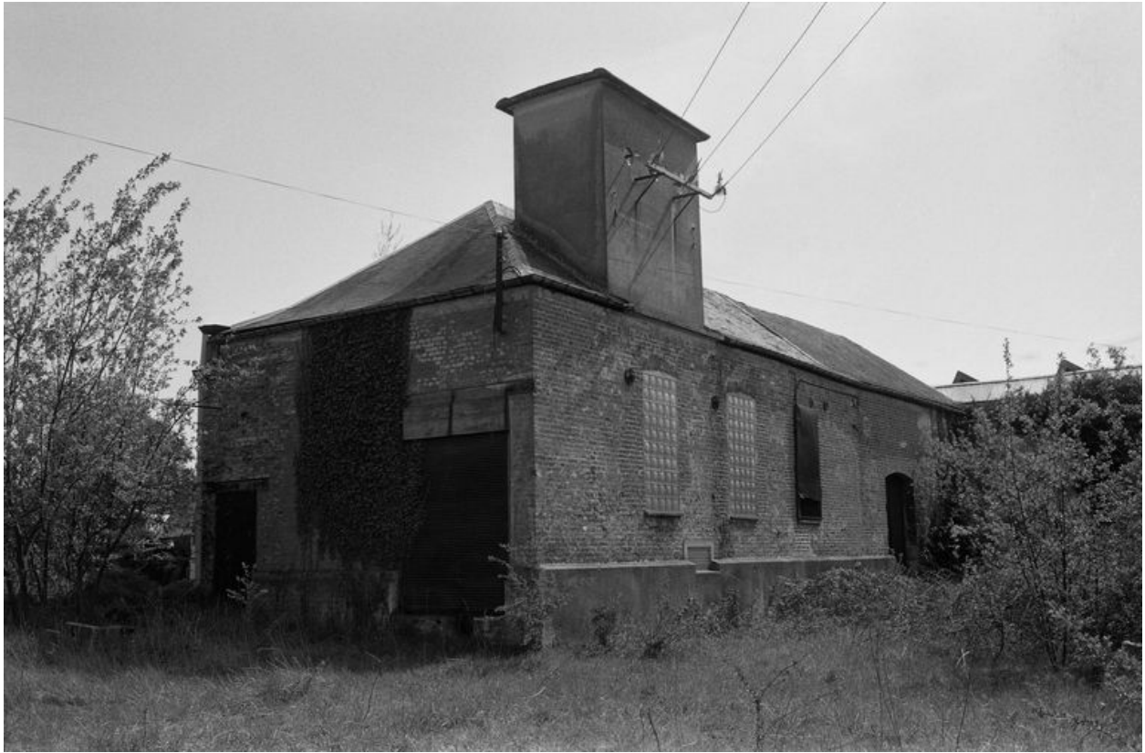
Chaufferie (?) et transformateur, en 1991.
