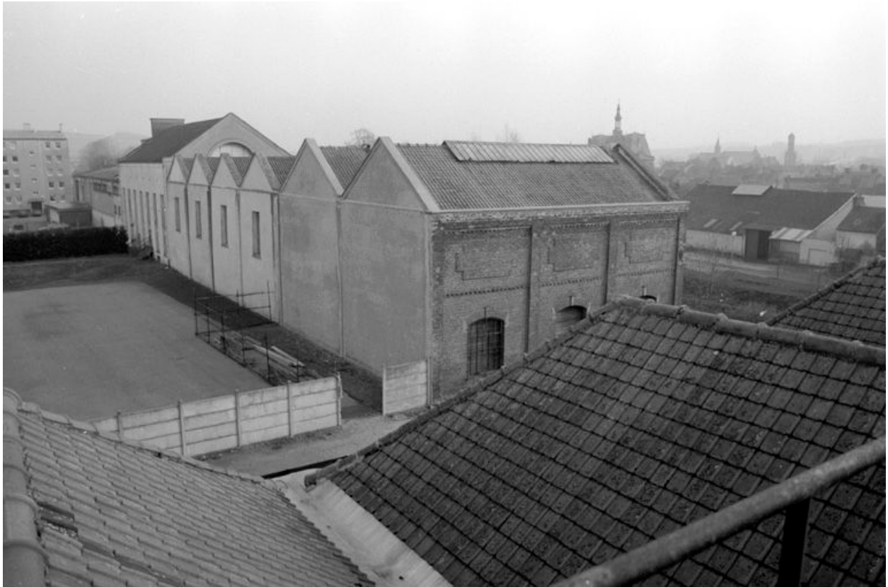
Vue générale des ateliers de fabrication et de la chaufferie, flanc nord.
