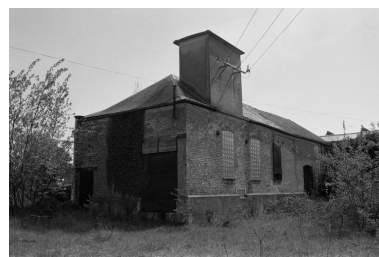
Chaufferie (?) et transformateur, en 1991. Phot. Benoît Dufournier IVR22_19918000541Z
