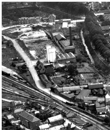
Vue aérienne en 1955, par Henrard (AD Somme ; 3 Fi 109). Phot. Monnehay-Vulliet Marie-Laure IVR22_20168000765NUC2A
