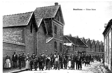
Sortie de l'usine, début du 20e siècle (coll. part.). Phot. Fournier Bertrand (reproduction) IVR22_20088015002NUCA
