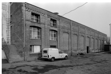
Atelier de fabrication est, en 1991 : élévation est. Phot. Benoît Dufournier IVR22_19918000330Z
