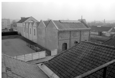
Vue générale des ateliers de fabrication et de la chaufferie, flanc nord. Phot. Benoît Dufournier IVR22_19918000334Z
