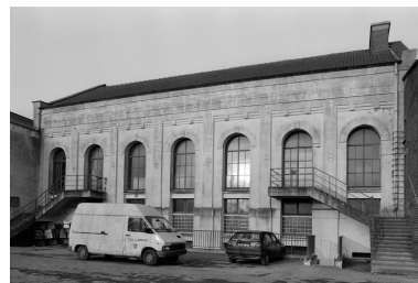
Salle des machines, en 1991 : élévation sud. Phot. Benoît Dufournier IVR22_19918000332Z
