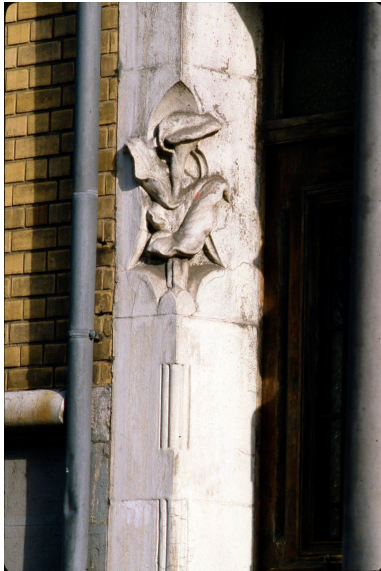
Façade sur voie, détail : chambranle de porte. Phot. Philippe Caudroit IVR31_19826200130ZA
