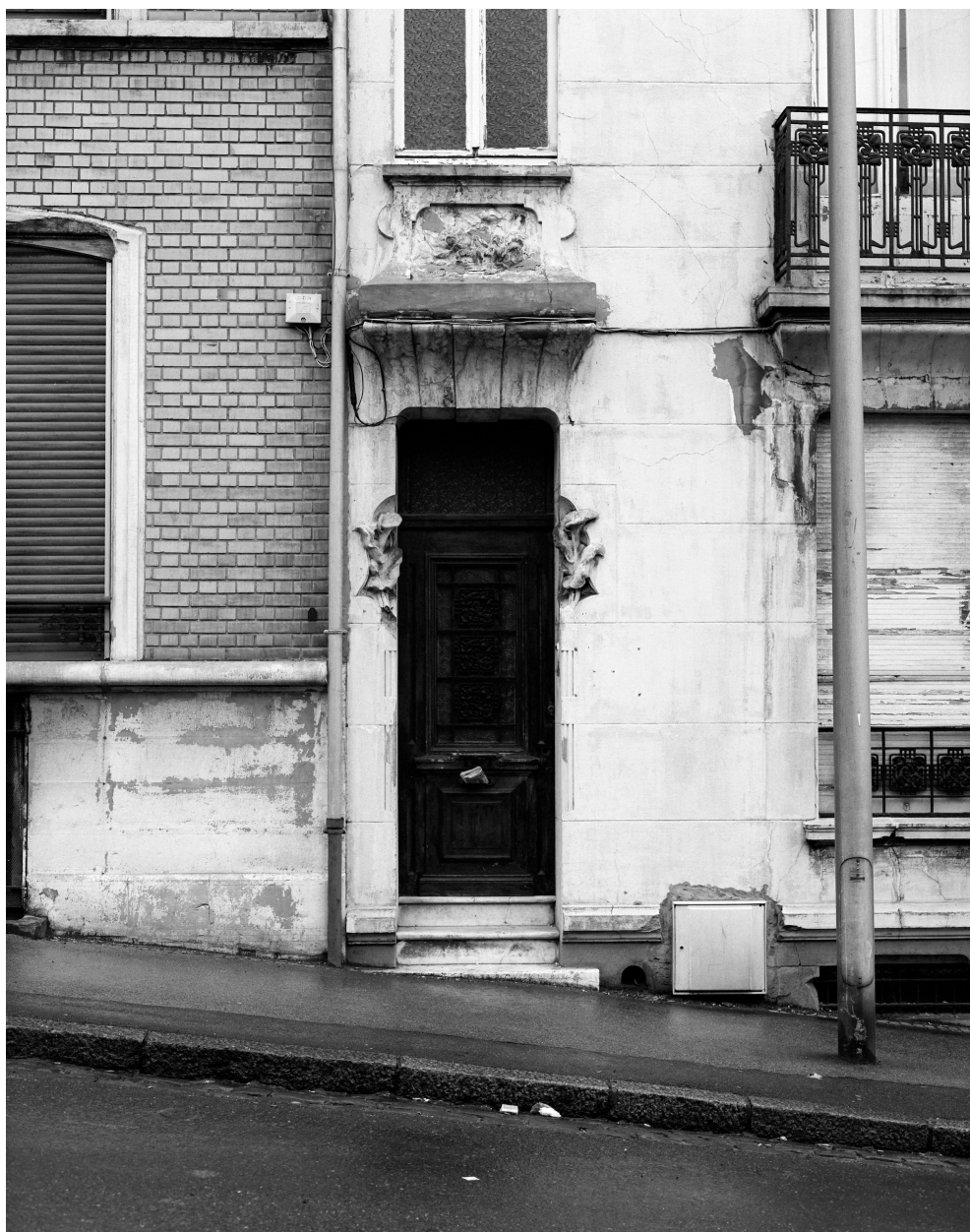
Façade sur voie, porte.
