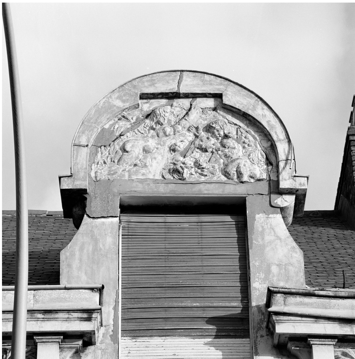
Façade sur voie, lucarne, tympan.
