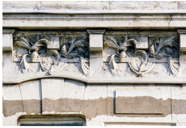
Façade sur voie, détail : corniche. Phot. Philippe Caudroit IVR31_19826200131ZA
