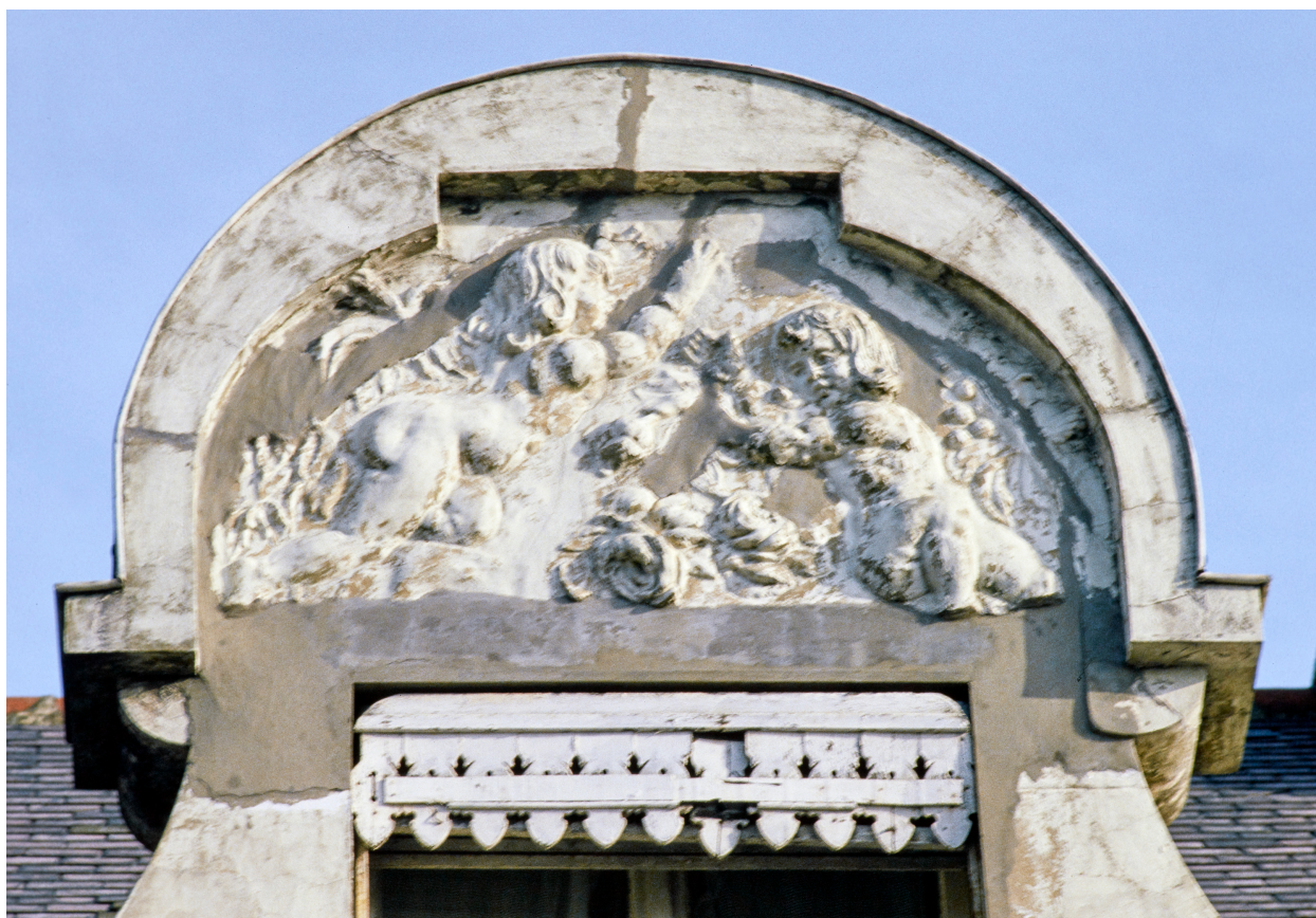
Façade sur voie, détail : tympan de lucarne.
