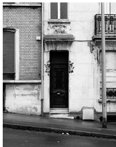
Façade sur voie, porte. Phot. Philippe Dapvril IVR31_19946200229X
