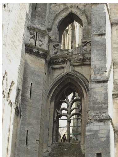
Baies ouest du bas-côté sud Phot. Bruno Decrock IVR31_20106202260NUCA
