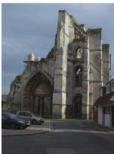
Vue générale de la façade ouest Phot. Bruno Decrock IVR31_20106202261NUCA
