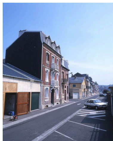
Vue de la rue Paul-Viguer, vers l'est. Phot. Marie-Laure Monnehay-Vulliet IVR22_20048000089XA
