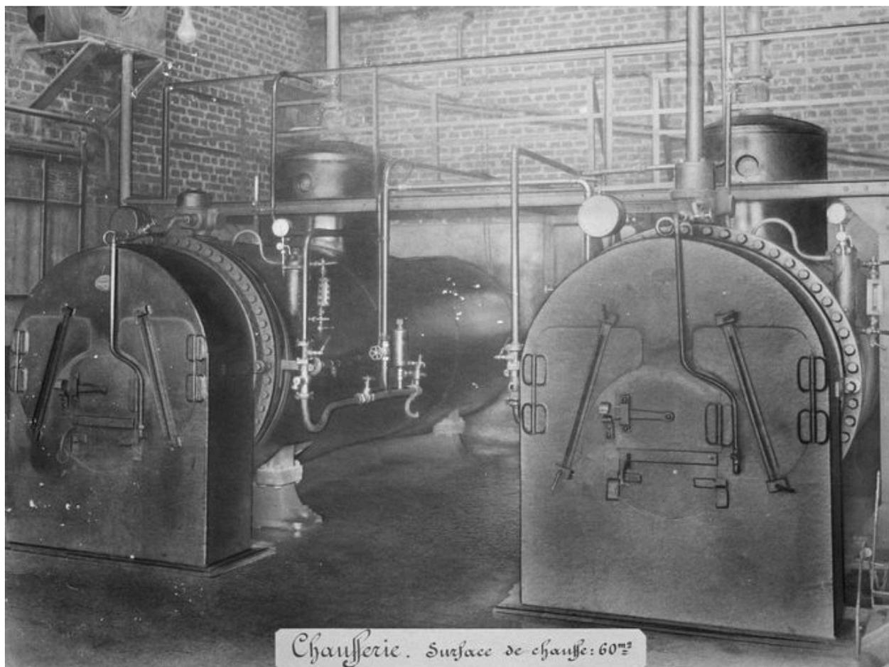
Intérieur de l'ancienne chaufferie avec les deux chaudières tubulaires d'une surface de chauffe de 60 m<sup>2</sup> (AP).
