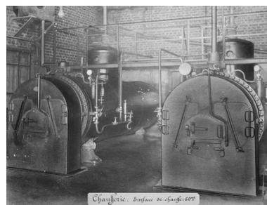
Intérieur de l'ancienne chaufferie avec les deux chaudières tubulaires d'une surface de chauffe de 60 m<sup>2</sup> (AP).
