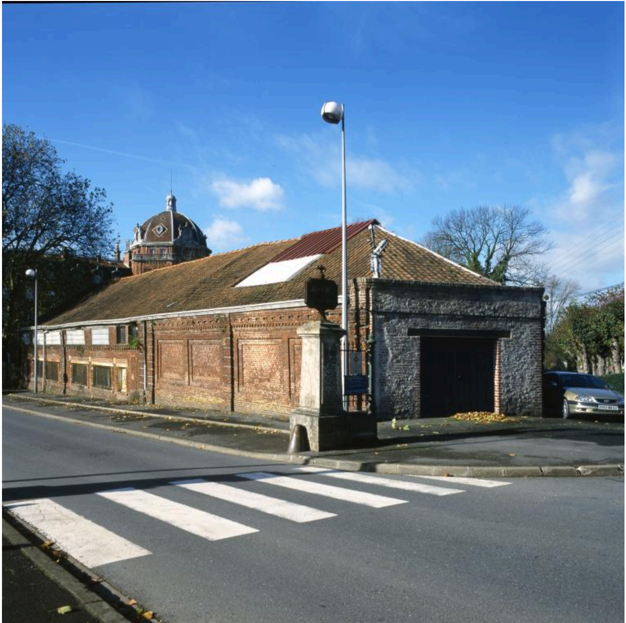
Vue générale des bâtiments qui abritaient la piscine, les bains publics et le lavoir du Familistère.
