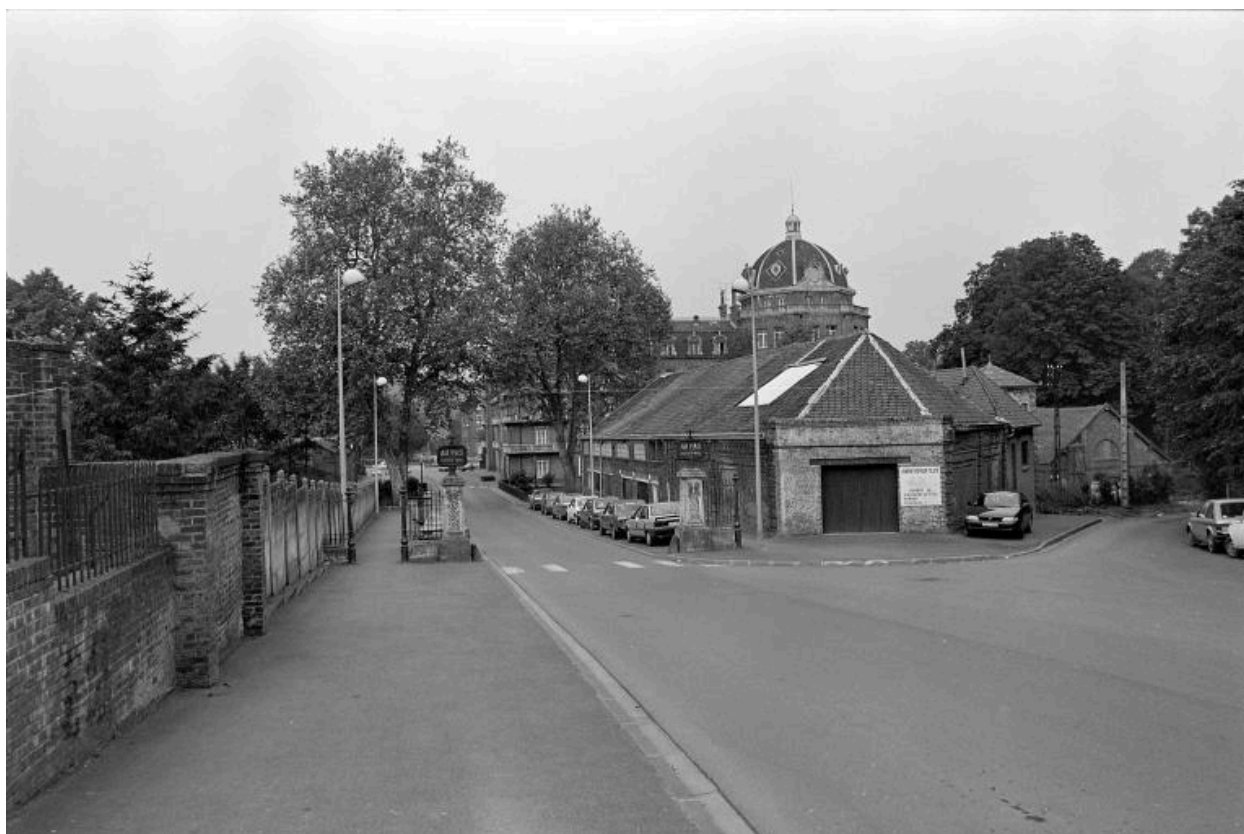
Vue générale des bâtiments.
