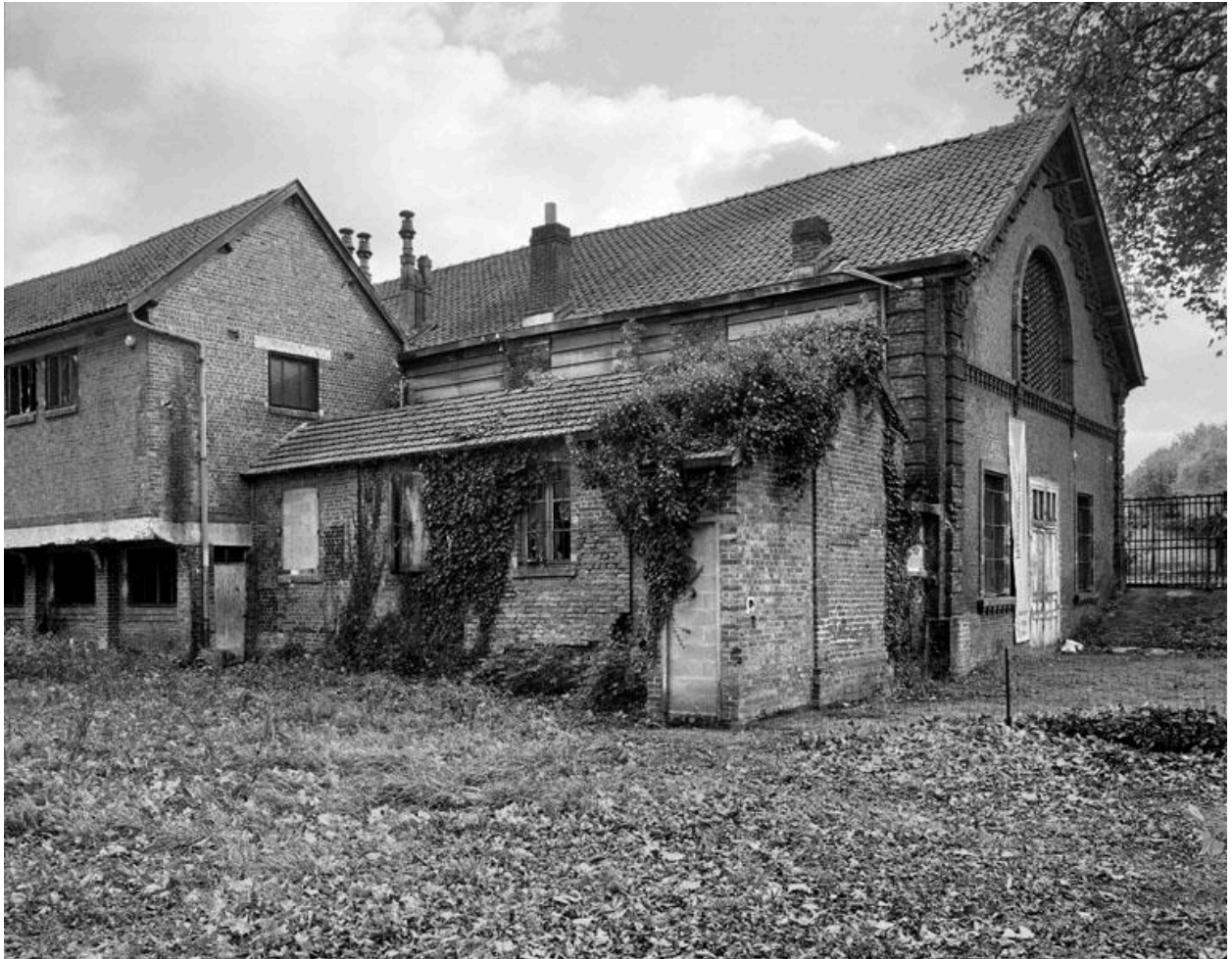
Vue arrière des bâtiments.
