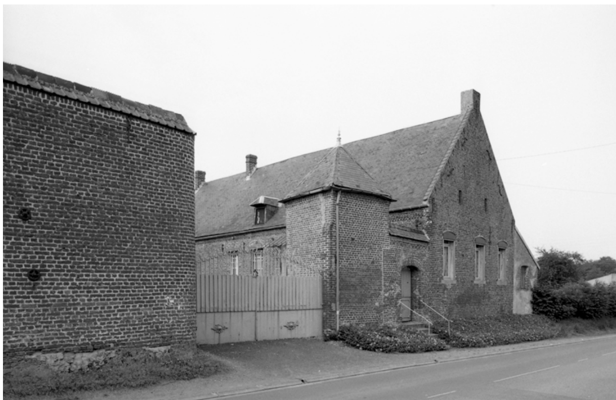
Vue d'ensemble des élévations sud, sur rue.
