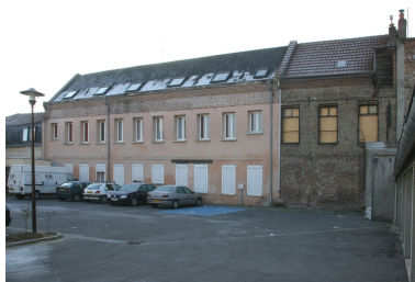
Façade postérieure des anciens ateliers, rue des Cordeliers. Au premier plan, le parking où se dressaient les ateliers détruits au début des années 2000. Phot. Frédéric Pillet IVR22_20050206162NUCA
