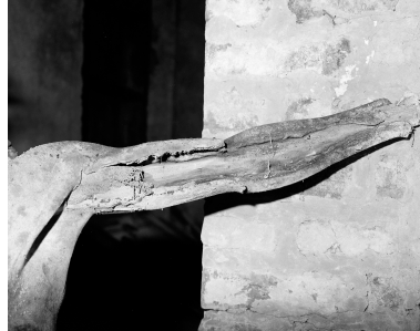
Bras, structure : détail. Phot. Jean-Michel Périn IVR31_19876202000X
