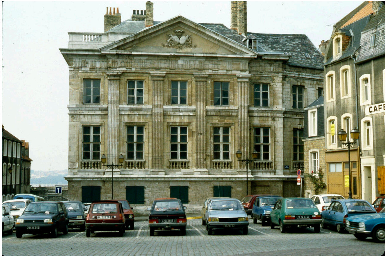
Façade sur la place Godefroy de Bouillon.
