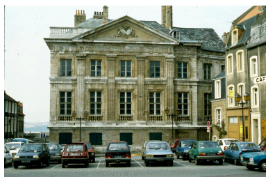
Façade sur la place Godefroy de Bouillon. Phot. Jean-Michel Périn IVR31_19876201460ZA
