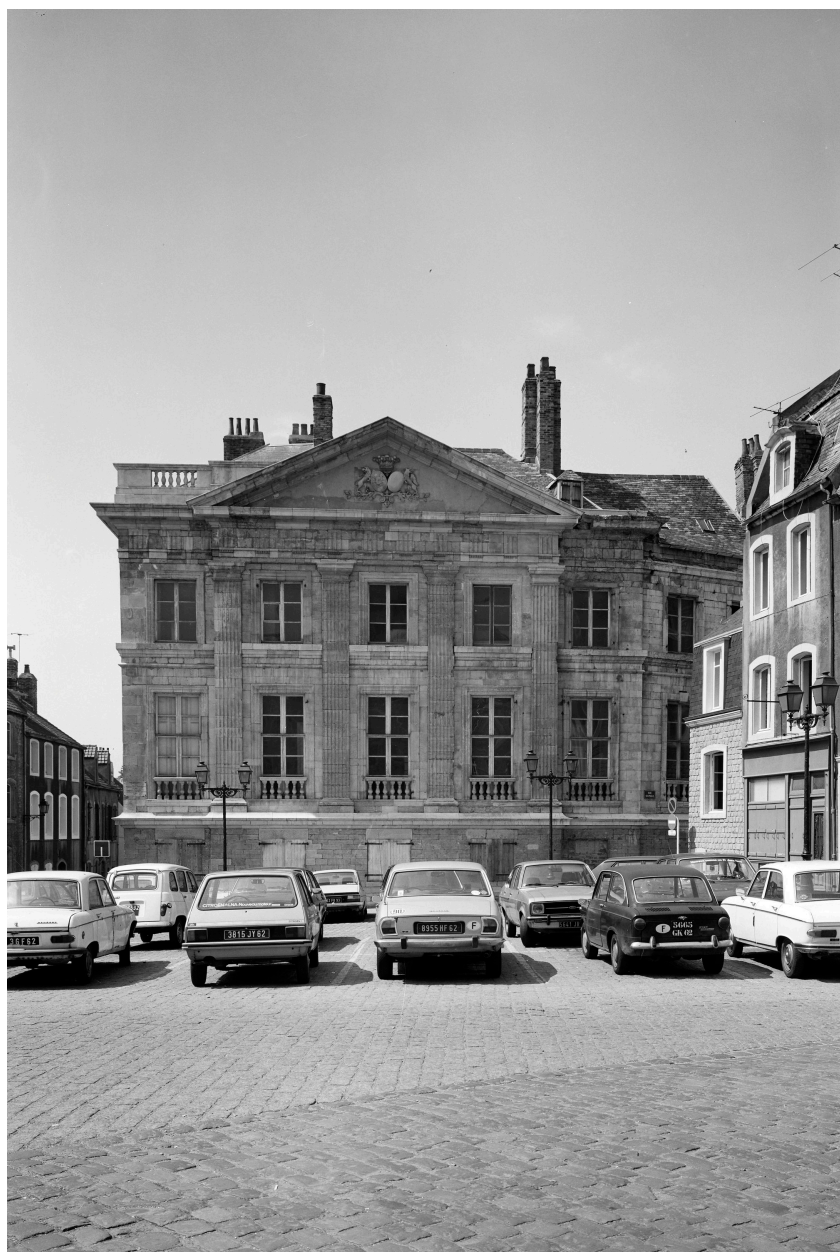
Façade sur place Godefroy de Bouillon.
