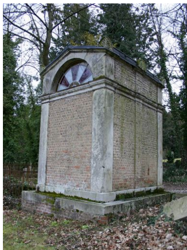
Vue générale postérieure. Phot. Caroline Vincent IVR22_20098000587NUCA
