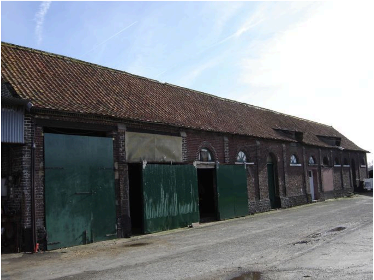
Vue partielle des écuries.
