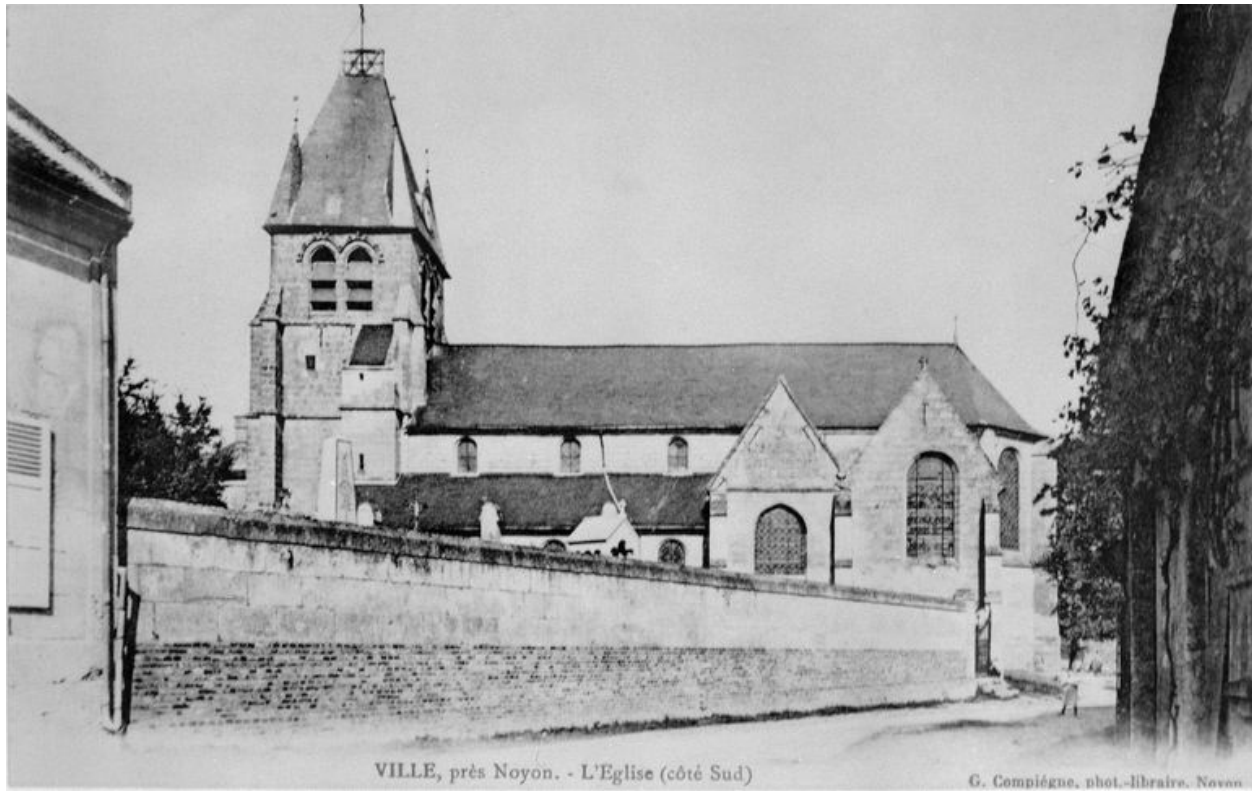
Elévation sud avant 1914 (AP).
