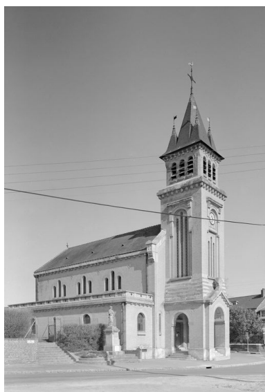
Elévation nord-ouest. Phot. Jean-Michel Perrin IVR22_19856000549X
