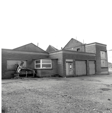
Élévation postérieure. Phot. Olivier Marlard IVR31_19895900428X
