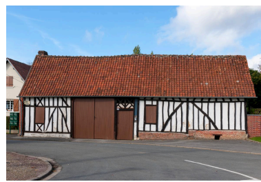
Ancienne grange avec porte à engranger et entrées charretière et piétonne, n°2 rue du Bois, vue depuis l'est. Phot. Marc Kérignard IVR32_20226001151NUCA
