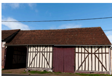
Ancienne grange avec entrée charretière, n°7 rue de la Mairie, vue depuis le sud-est. Phot. Marc Kérignard IVR32_20226001146NUCA
