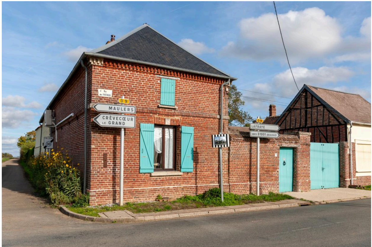
Logis n°14 rue des Frênes, reconstruit en 1860 (date portée), vue depuis l'ouest.
