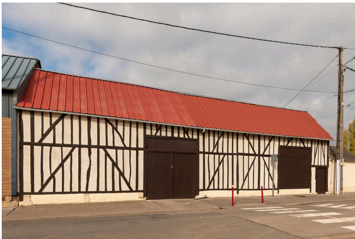
Ancienne grange avec entrée charretière comblée, n°2 rue de la Place, vue depuis le sud-est.
