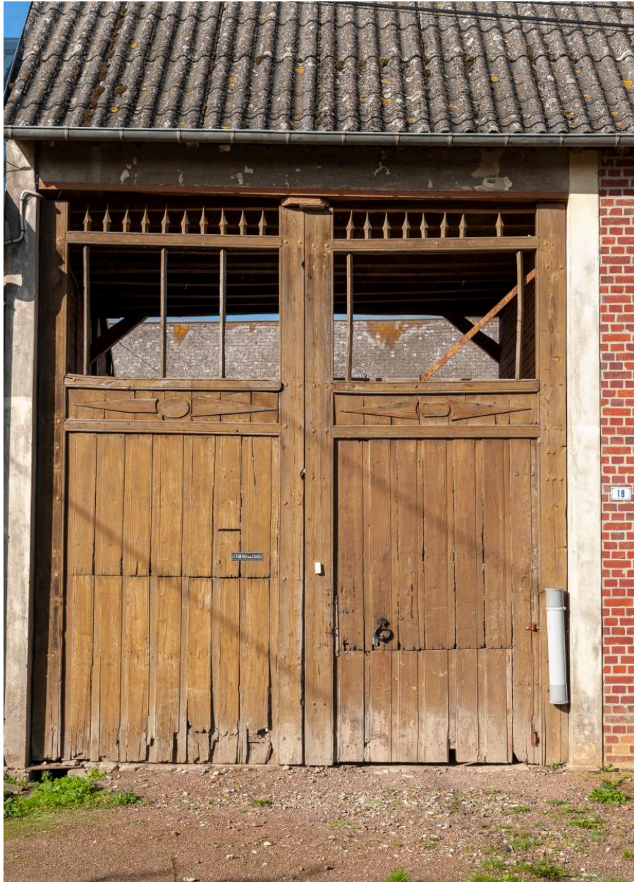
Porte charretière, n°19 rue de la Mairie.
