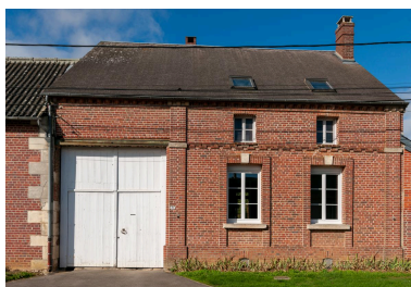
Maison de commerçant ou d'artisan (?), n°21 rue de la Mairie, vue depuis le sud-est. Phot. Marc Kérignard IVR32_20226001150NUCA
