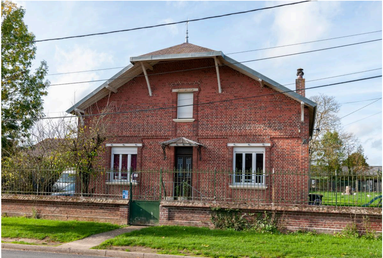
Logis en retrait de la rue, n°27 rue de la Mairie, vue depuis le sud-est.
