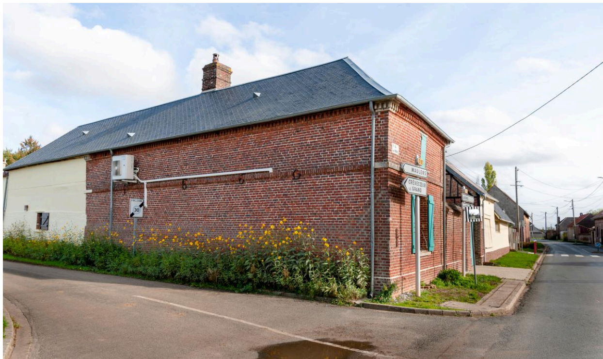
Côté nord du logis n°14 rue des Frênes, date portée "1860".
