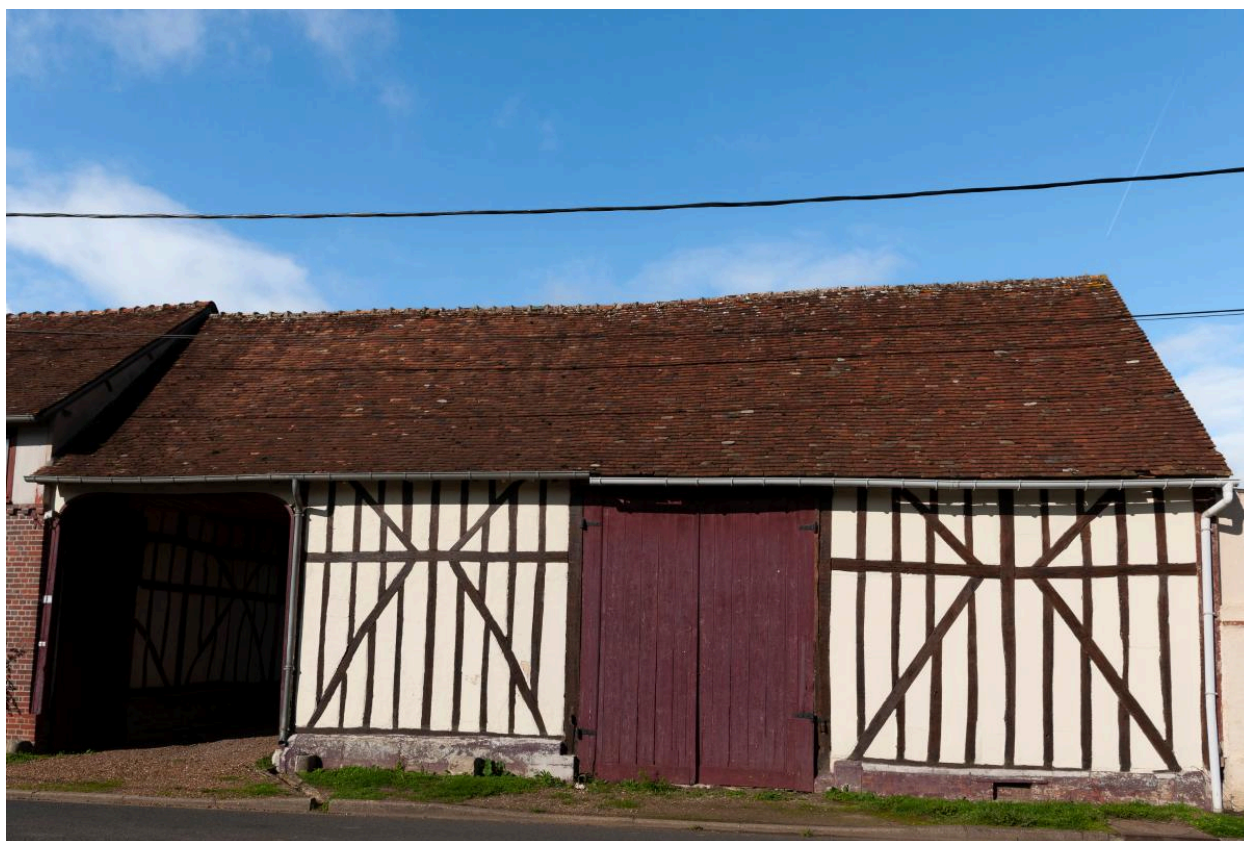
Ancienne grange avec entrée charretière, n°7 rue de la Mairie, vue depuis le sud-est.
