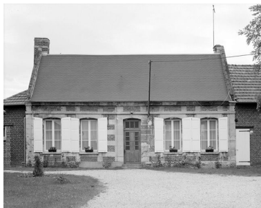
Logis. Elévation antérieure. Phot. Jean-Michel Perrin IVR22_19856000992V
