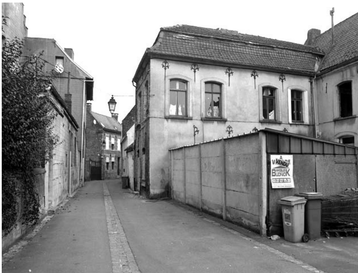
Aile en retour, vue générale.
