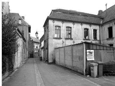
Aile en retour, vue générale. Phot. Pierre Thibaut IVR31_20065900299X
