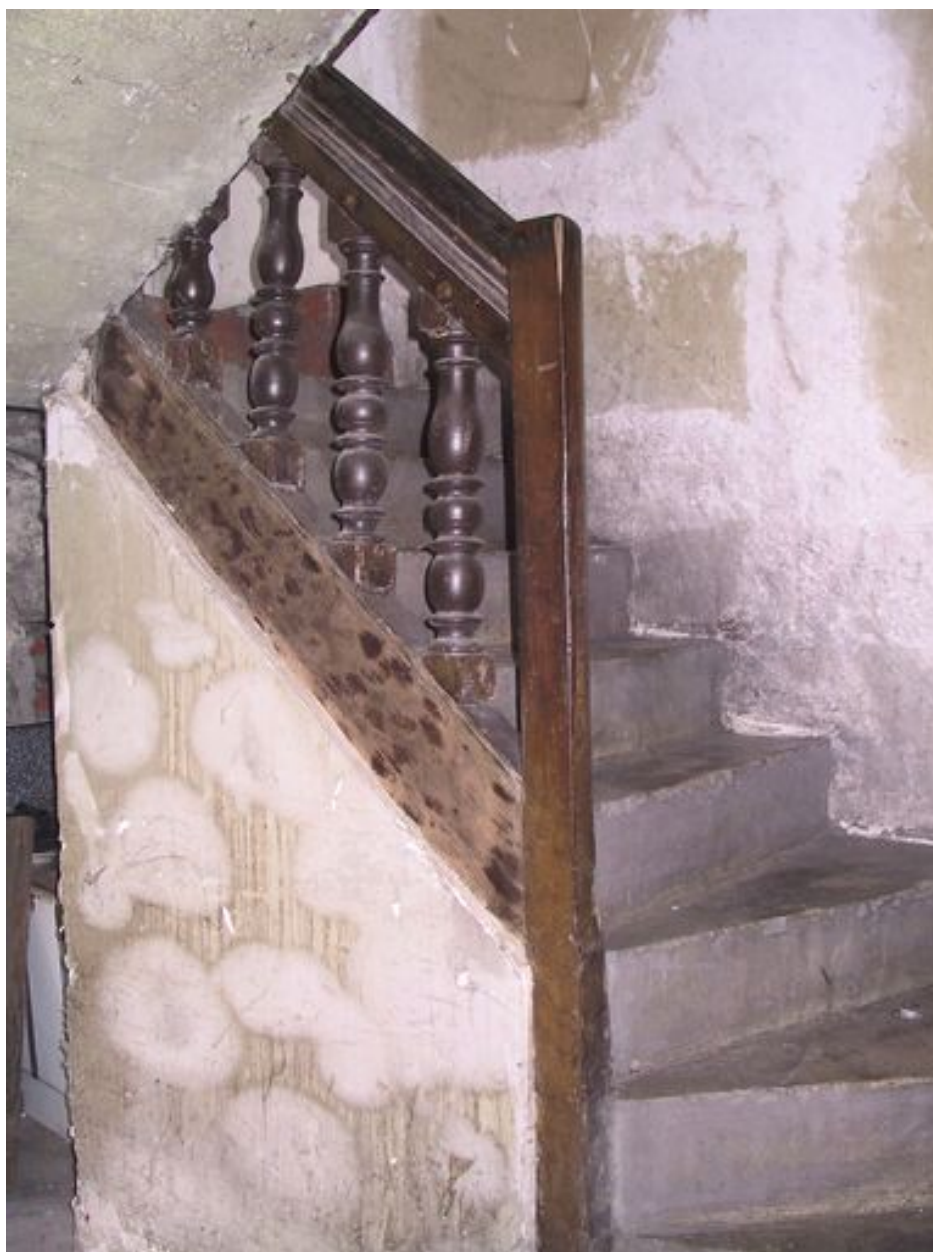
Corps de logis principal, partie gauche, intérieur, rez-de-chaussée : escalier.
