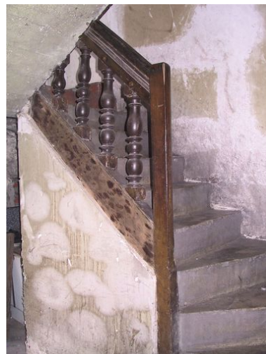
Corps de logis principal, partie gauche, intérieur, rez-de-chaussée : escalier. Phot. Olivier Liardet IVR31_20065906288NUCA
