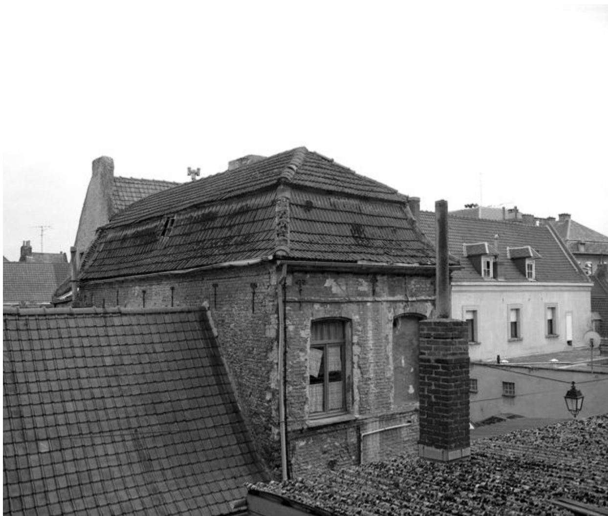
Aile en retour : étage et comble ; à droite en arrière-plan, le corps de logis principal.
