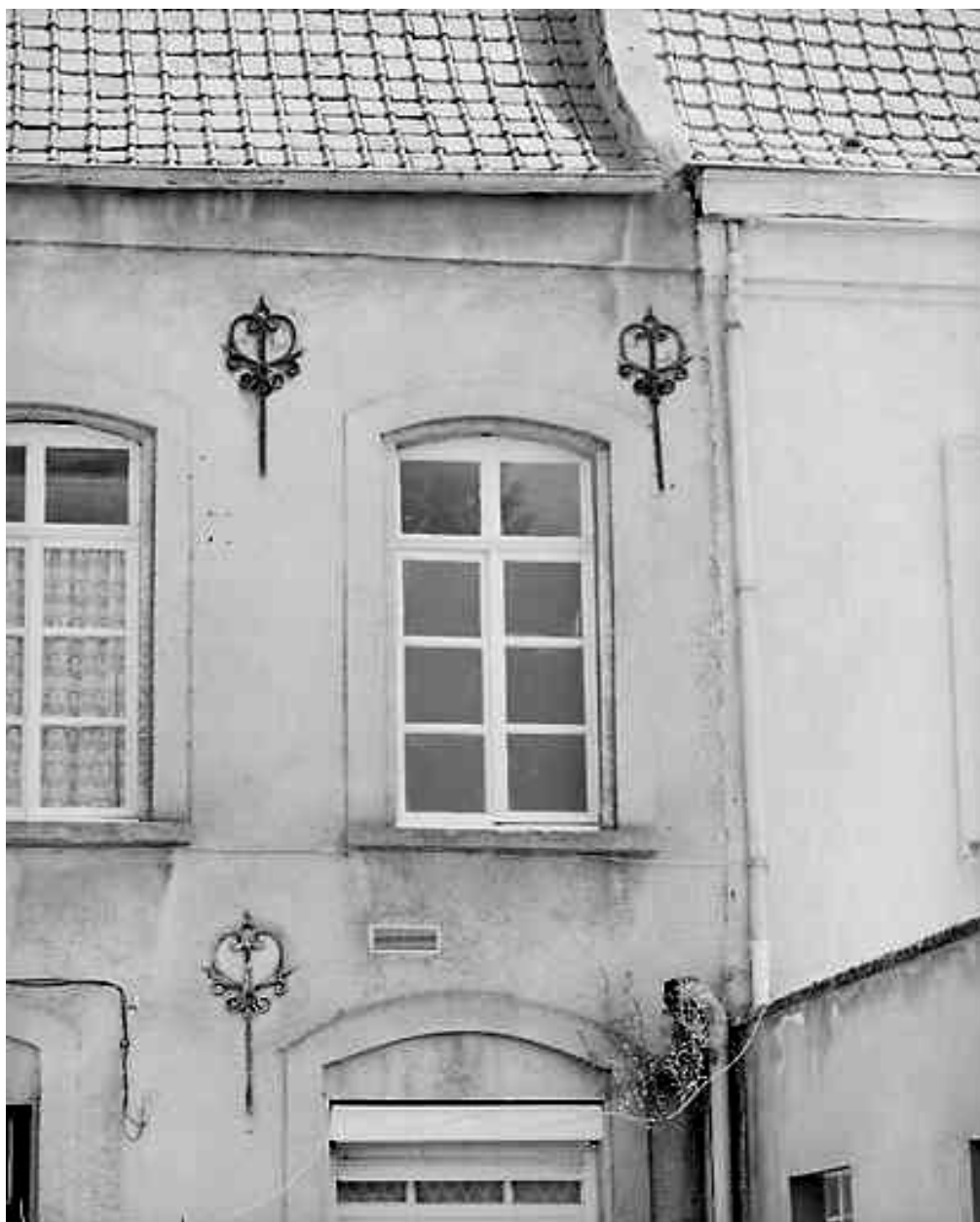
Corps de logis principal, partie gauche, détail : baies et ancres en ferronnerie.
