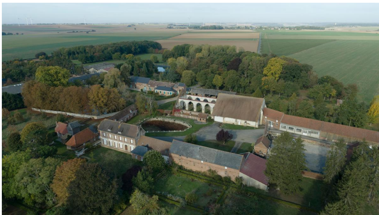
Vue aérienne des fermes depuis le sud-est.
