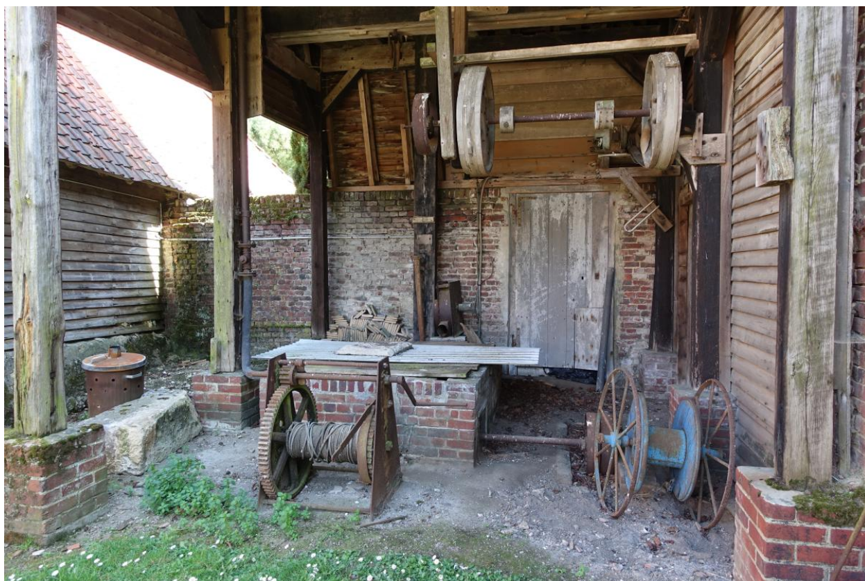
Détail du mécanisme de pompage du puits.
