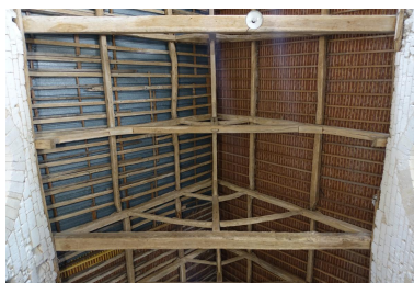
Charpente. Phot. Lucile Chamignon IVR32_20226005082NUCA
