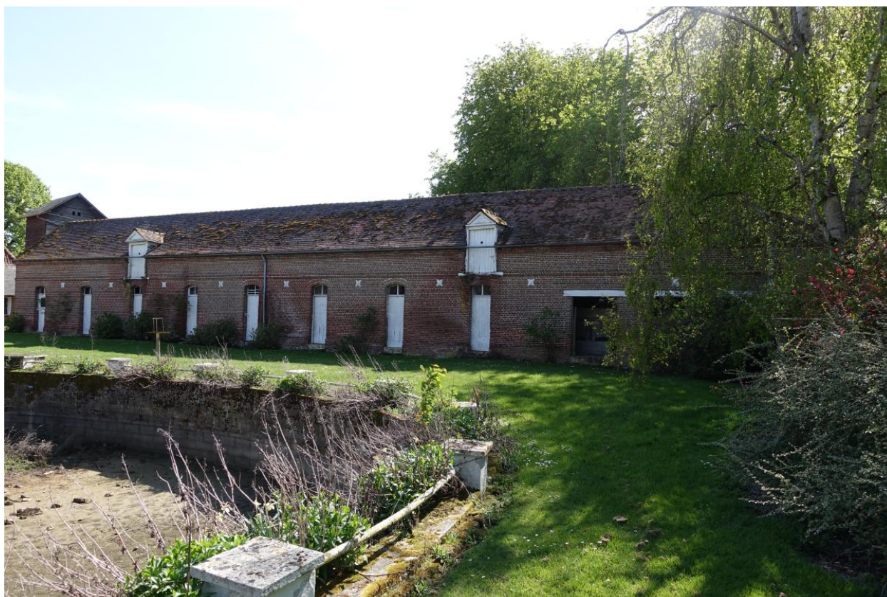
Anciennes porcheries, vue depuis le nord-est.
