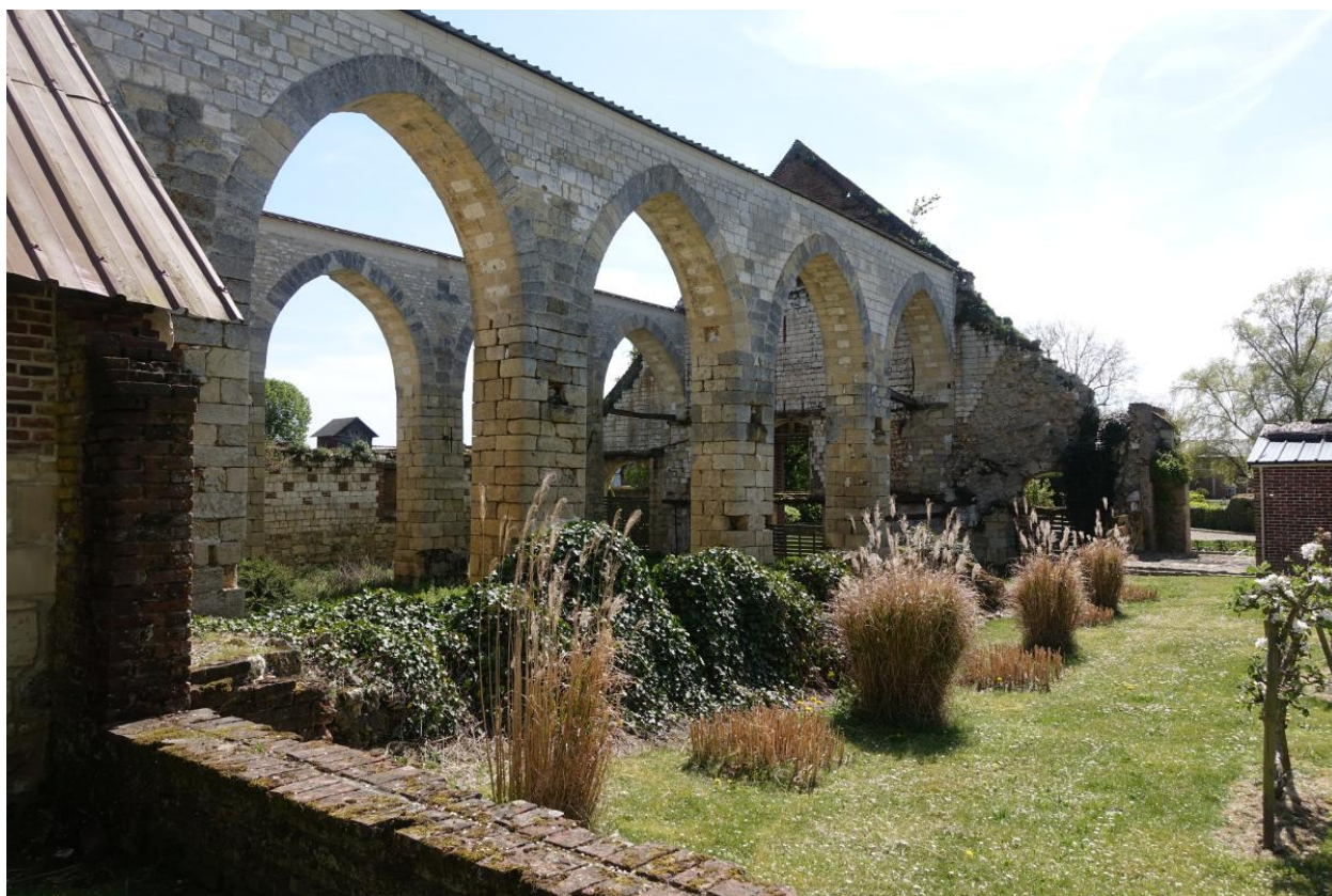
Vue de la grange depuis le nord-est.
