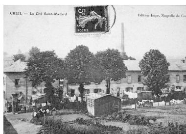
Usine I : La cité Saint-Médard et à l'arrière plan la cheminée de l'usine Vachette (AC Creil). Phot. Clarisse Lorieux (reproduction) IVR22_20066005021NUCAB
