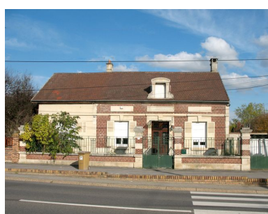
Maison du marbrier Eugène Wattebled à Nogent-sur-Oise construite en 1883 dans le quartier des briqueteries. Phot. Clarisse Lorieux IVR22_20096005045NUCA
