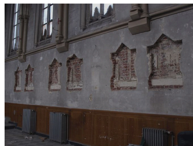
Chapelle, intérieur : traces d'arrachements du chemin de croix (nef). Phot. Bruno Decrock IVR31_20106202978NUCA
