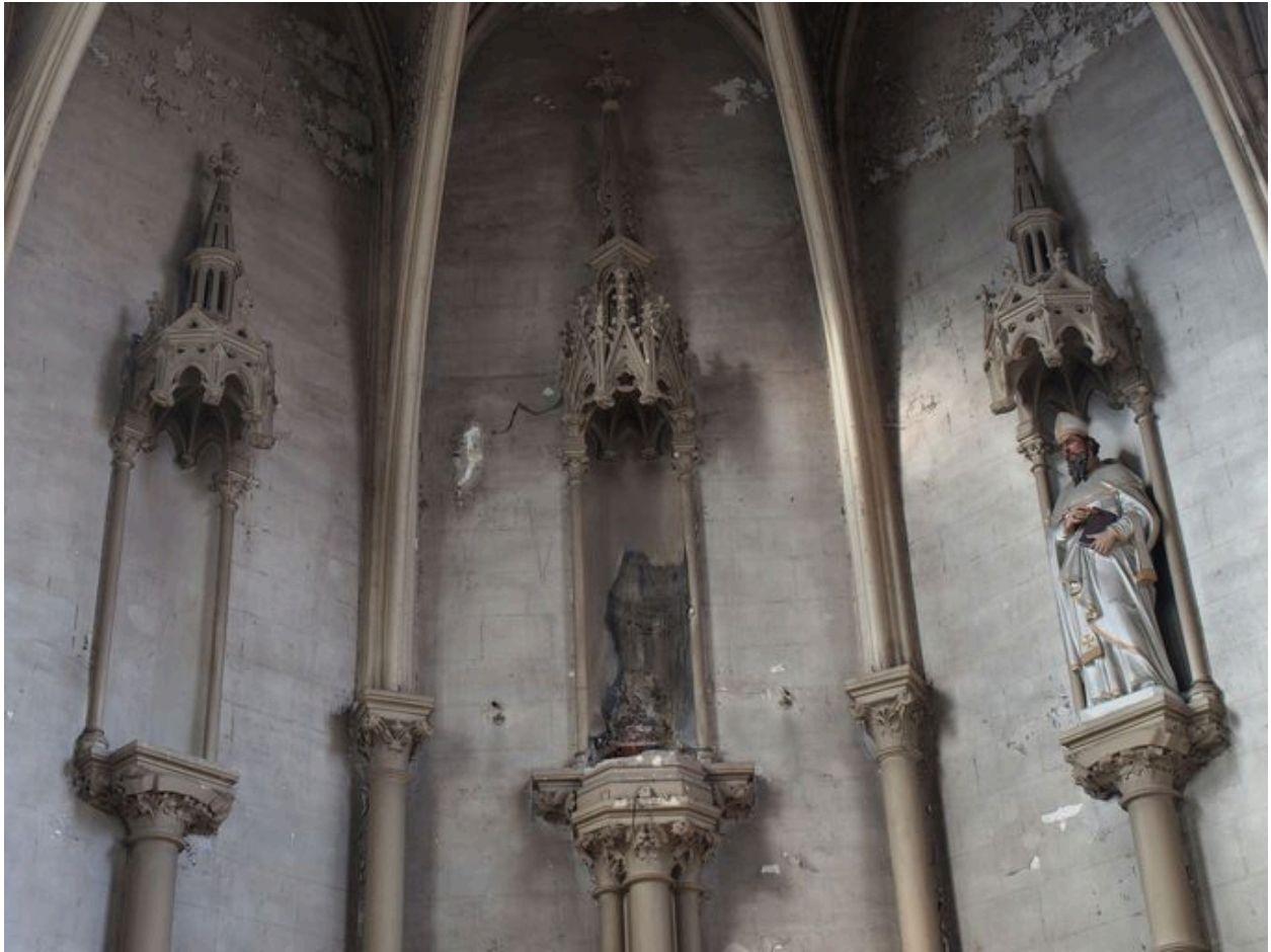
Chapelle, intérieur : emplacement des statues de l'abside ; saint évêque à droite sur l'image.
