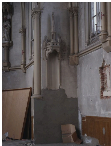
Chapelle, intérieur : emplacement des autels latéraux disparus (ici au sud).
