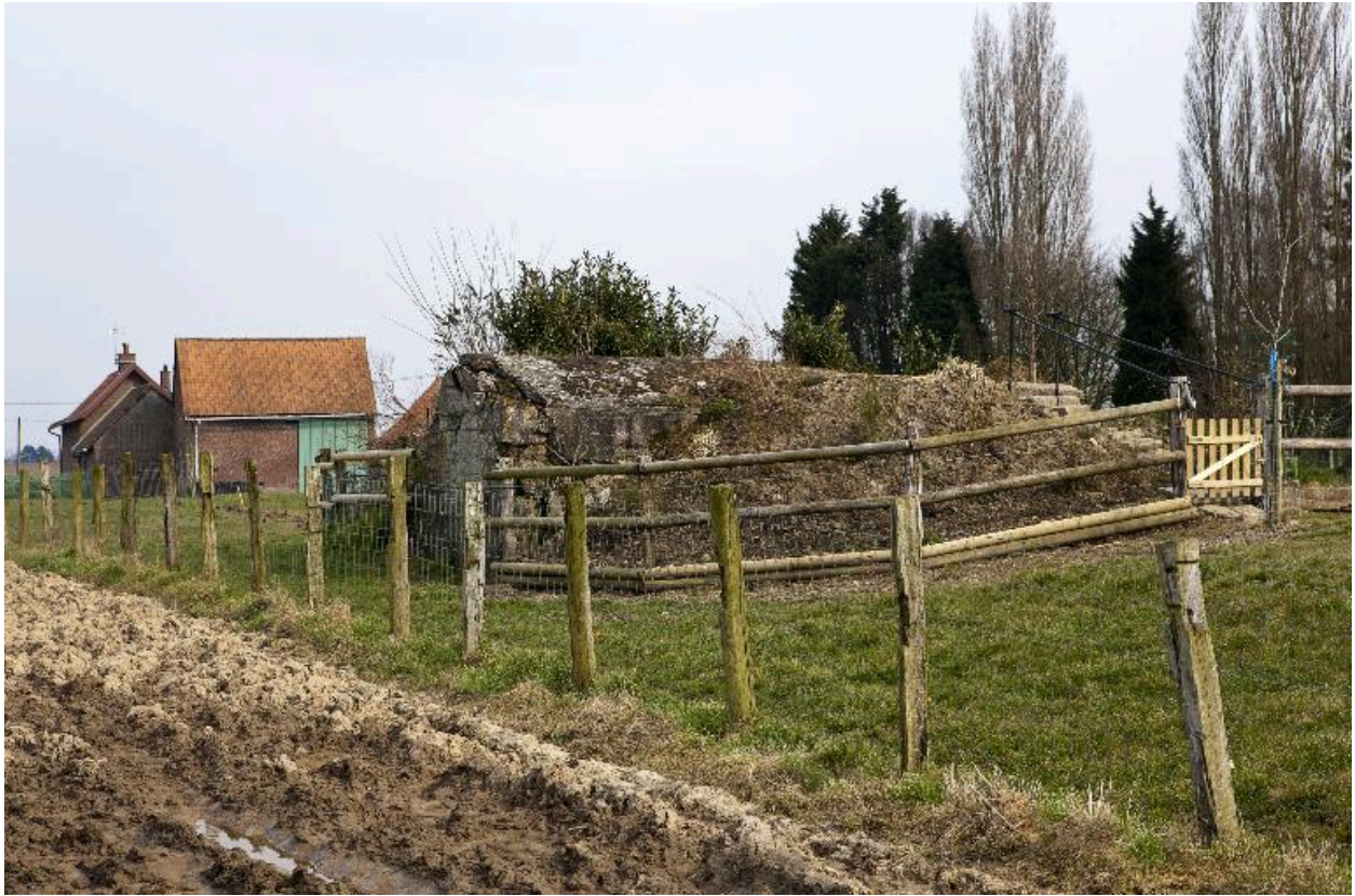
Vue de 3/ vers le sud-est
