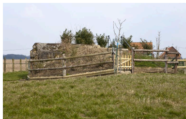
Vue latérale, vers l'ouest Phot. Jean-Marc Ramette IVR31_20145904632NUCA
