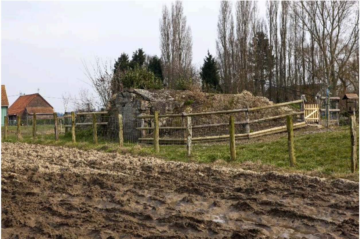
Vue de 3/ vers le sud-est
