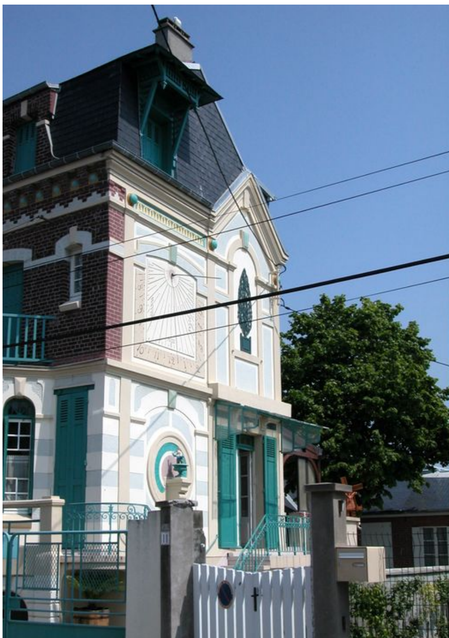
Vue rapprochée de la façade latérale droite.
