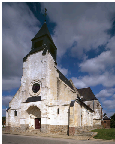
Vue générale depuis le sud-ouest. Phot. Irwin Leullier IVR22_19988000851VA
