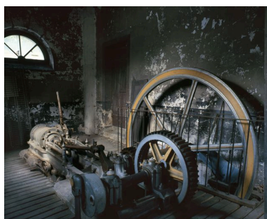
Vue générale. Phot. Thierry Lefébure IVR22_20006000663VA
