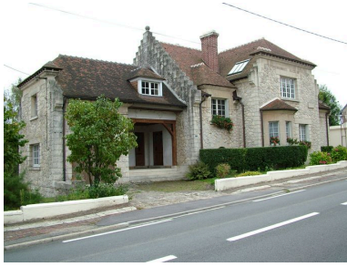
Vue générale de la façade. Phot. Inès Guérin IVR22_20050200627NUCA
