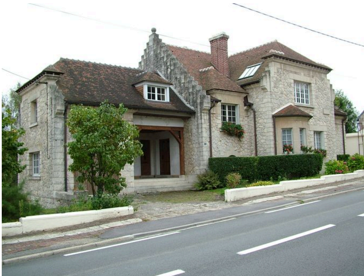
Vue générale de la façade.
