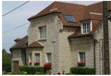
Autre vue de la façade. Phot. Inès Guérin IVR22_20050200628NUCA
