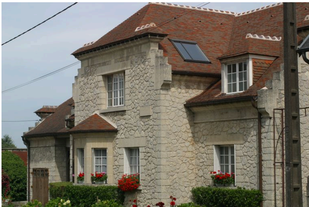
Autre vue de la façade.
