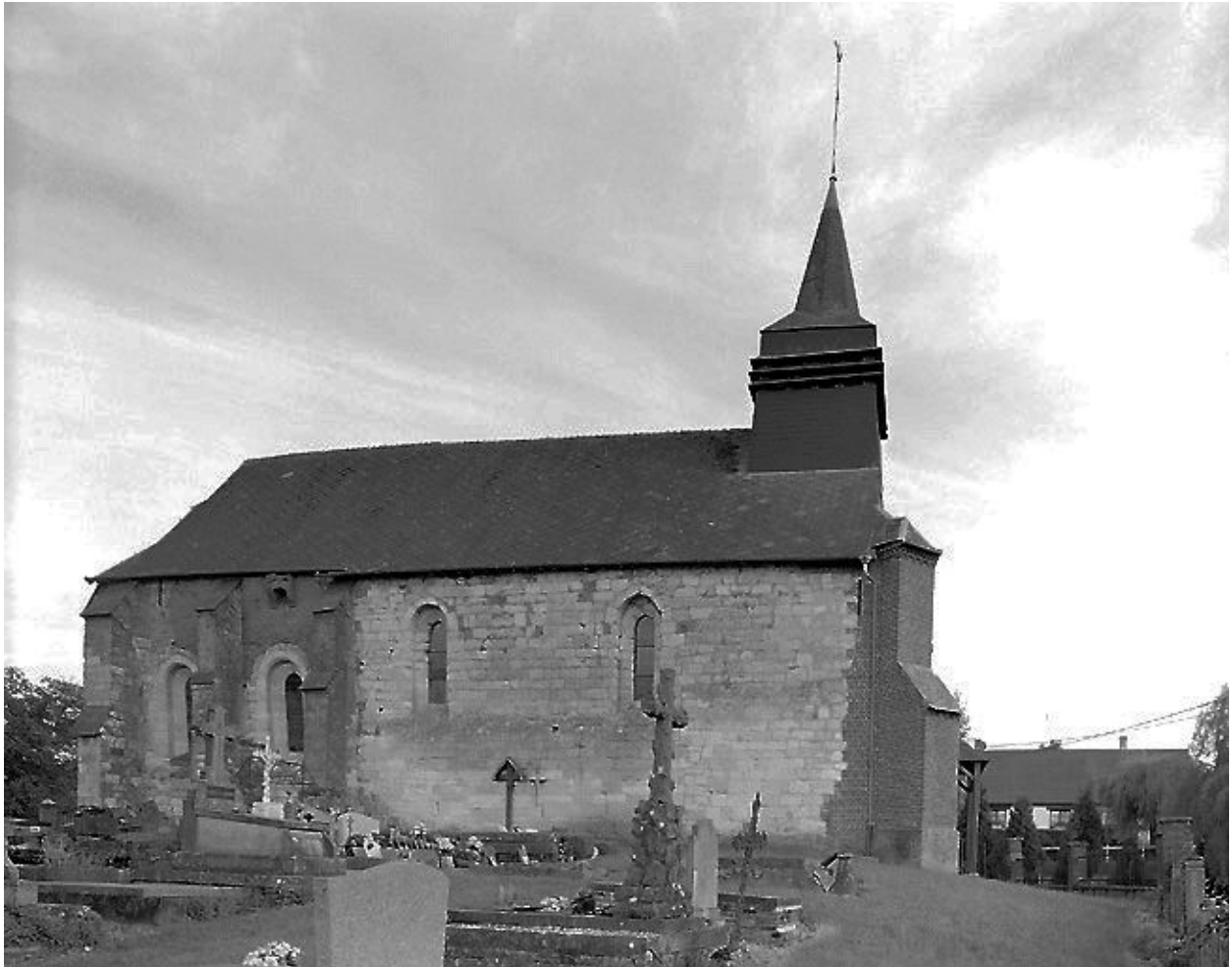
Elévation nord de l'église depuis le cimetière.
