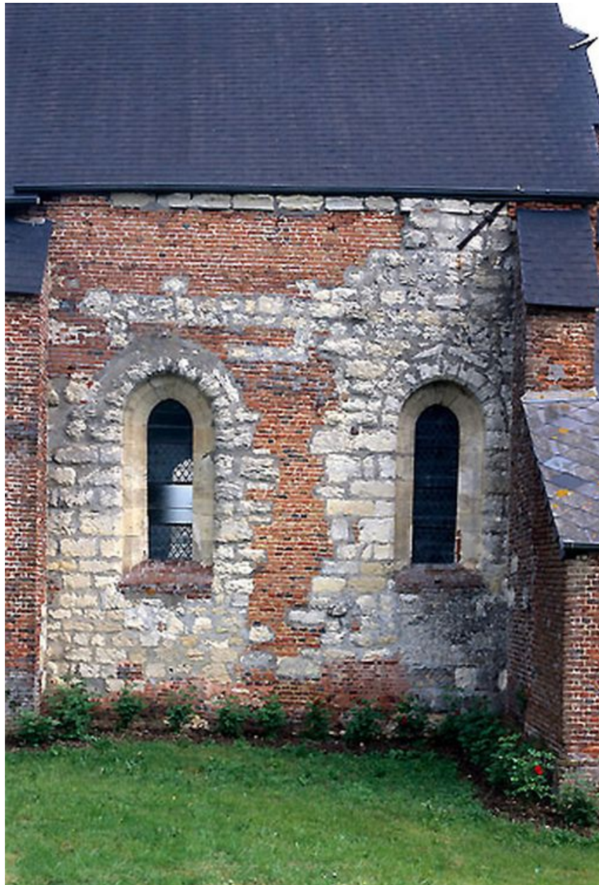
Détail de l'élévation sud du choeur avec les deux baies datant du 13e siècle.
