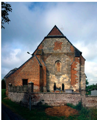
Vue du chevet avec la sacristie attenante. Phot. Laurent Jumel IVR22_19980201071XA
