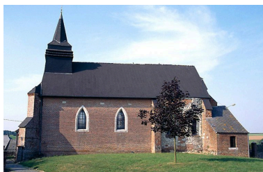
Élévation sud de l'église. Phot. Martine Plouvier IVR22_19990202266ZA
