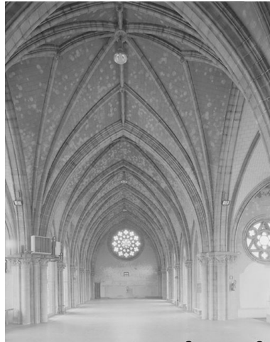
Vue intérieure vers l'entrée, partie haute. Phot. Michaël Troivaux IVR22_19968000348V
