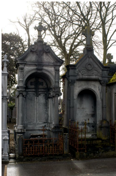
Vue de situation, tombeau à droite de l'image. Phot. Thierry Lefébure IVR22_20058000241NUCA
