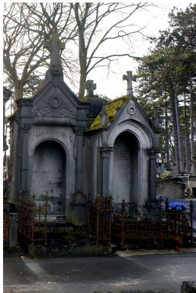
Vue générale, tombeau à gauche de l'image. Phot. Thierry Lefébure IVR22_20058000242NUCA
