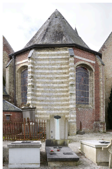
Chevet de l'église. Mur du chœur en "rouge-barre". Phot. Delphine Volto Jourdan IVR32_20255900445NUCA
