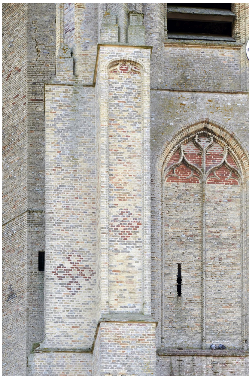
Façade ouest du clocher, détail.
