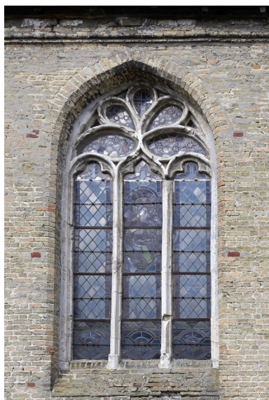
Baie du bas-côté sud. Gothique flamboyant tardif. Phot. Delphine Volto Jourdan IVR32_20255900902NUCA
