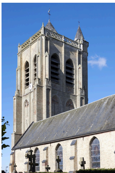
Vue générale depuis le sud-est. Phot. Delphine Volto Jourdan IVR32_20255900618NUCA
