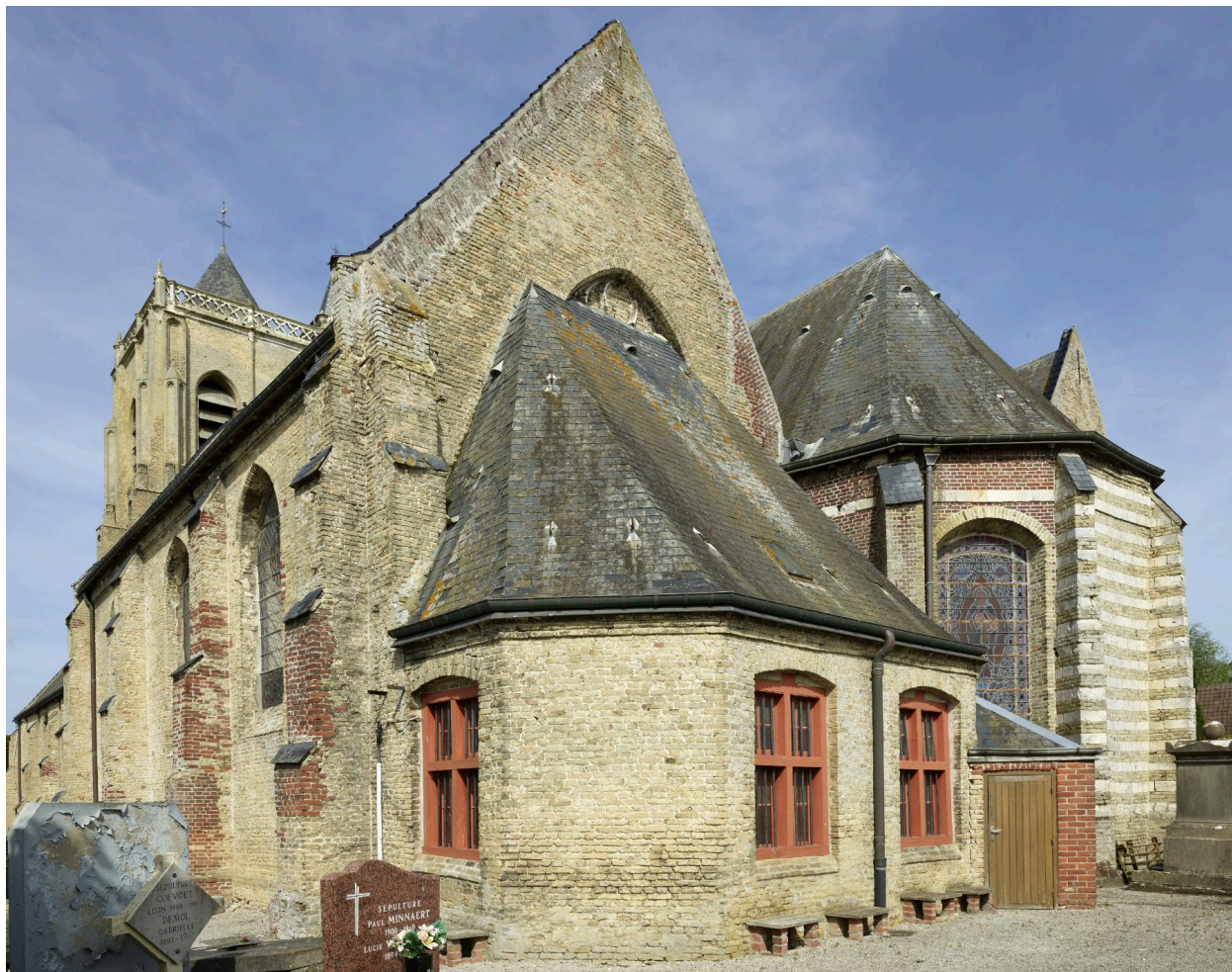
Vue de l'arrière de l'église. Bas-côté sud et sacristie au premier plan.
