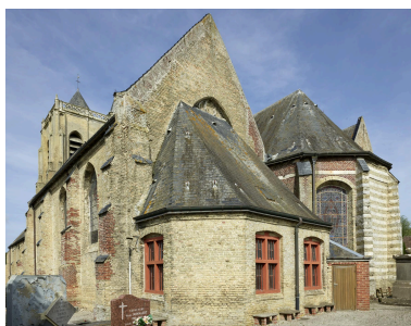
Vue de l'arrière de l'église. Bas- côté sud et sacristie au premier plan. Phot. Delphine Volto Jourdan IVR32_20235900820NUCA
