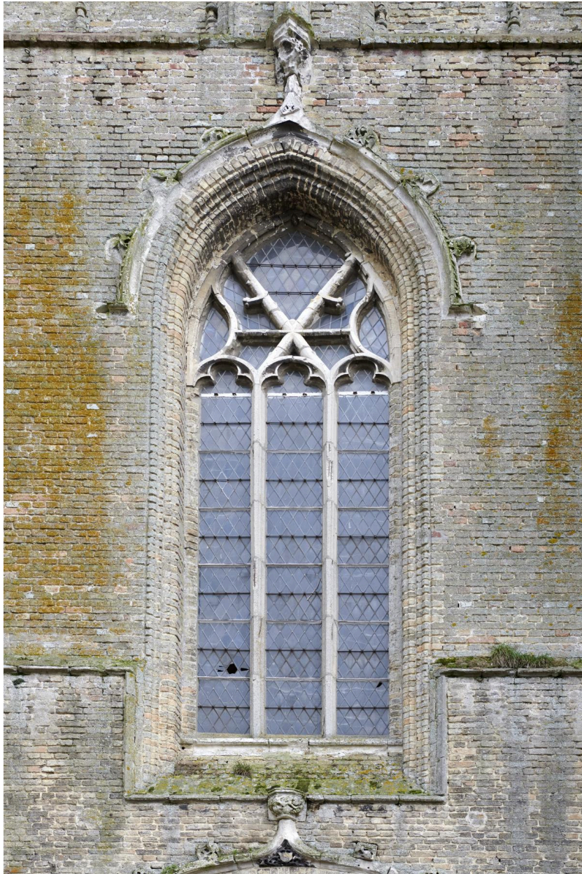
Baie du bas-côté nord. Gothique flamboyant tardif.
