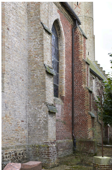
Diversité des matériaux de construction, exemple. Phot. Delphine Volto Jourdan IVR32_20255900456NUCA
