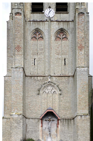
Face sud du clocher. Phot. Delphine Volto Jourdan IVR32_20255900470NUCA
