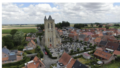
Vue aérienne générale. Phot. Delphine Volto Jourdan IVR32_20255901398NUCA
