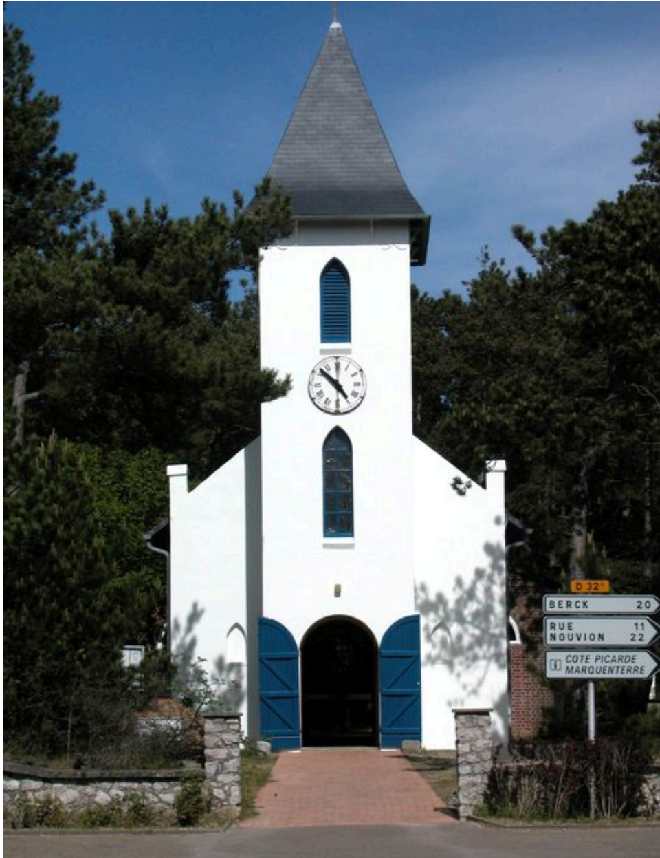
Vue d'ensemble de la façade repeinte.
