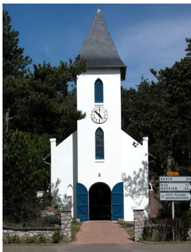
Vue d'ensemble de la façade repeinte.
