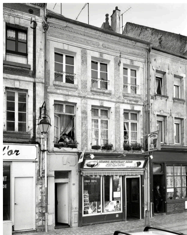
Vue de la façade sur rue. Phot. Thierry Lefébure IVR22_20020200823V
