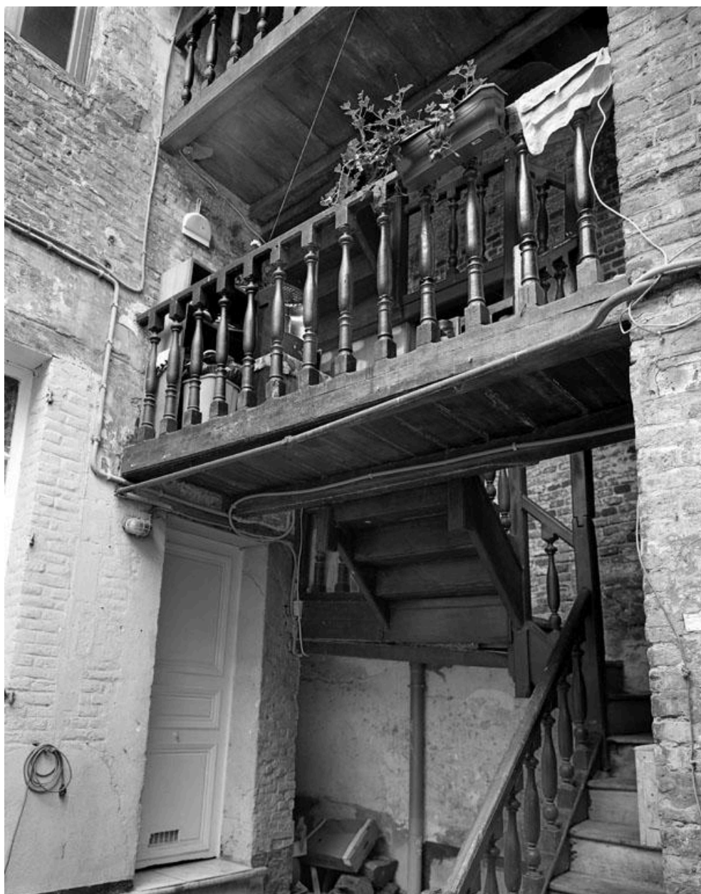
Vue de l'escalier de la cour arrière, qui relie le bâtiment principal au second logis.
