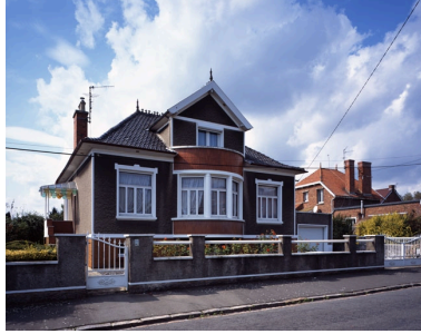
Vue générale d'une maison. Phot. Pierre Thibaut IVR31_20085900865VA
