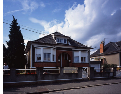
Vue générale d'une maison. Phot. Pierre Thibaut IVR31_20085900864VA
