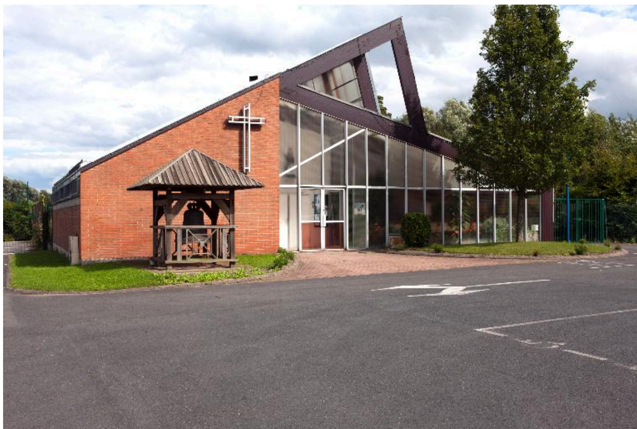
Vue de la façade occidentale.
