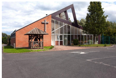
Vue de la façade occidentale. Phot. Pierre Thibaut IVR31_20145903214NUCA
