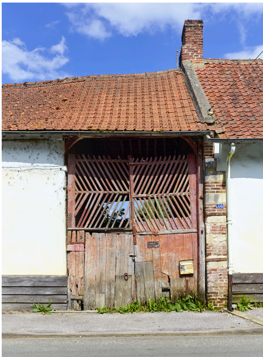
Détail de la porte charretière, depuis l'ouest.
