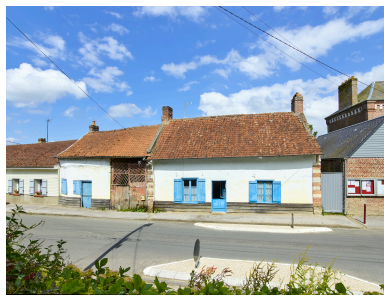
Ensemble de la ferme, depuis l'ouest.
