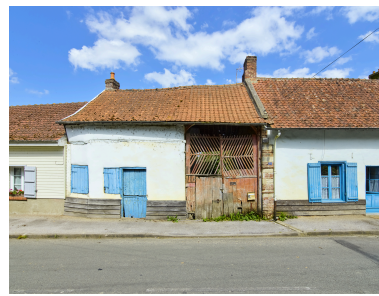
Vue de la grange, depuis l'ouest.
