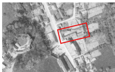
La ferme en 1970 (IGN. Photothèque nationale. Remonter le temps). Phot. Institut Géographique National IVR32_20248005553NUCA
