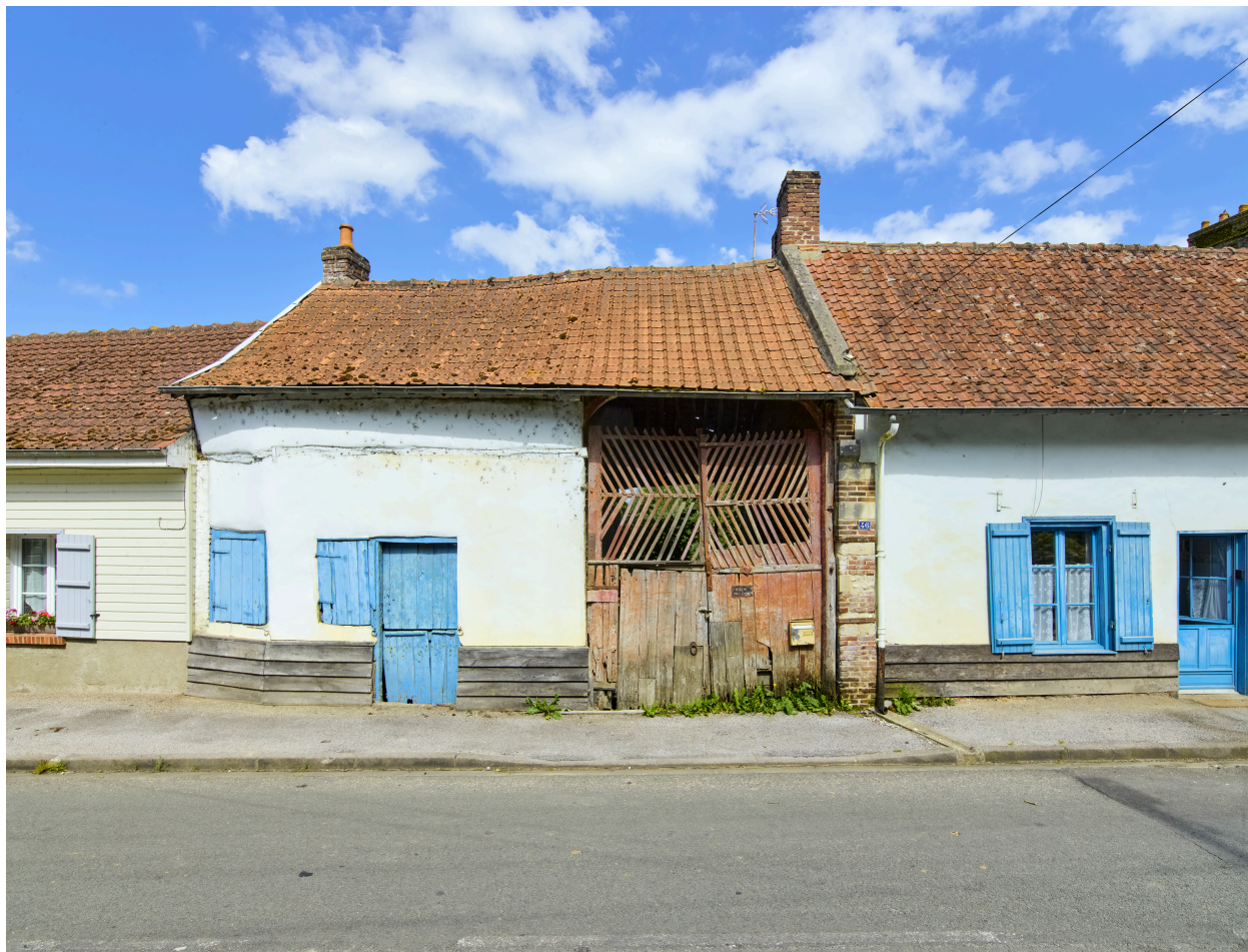
Vue de la grange, depuis l'ouest.
