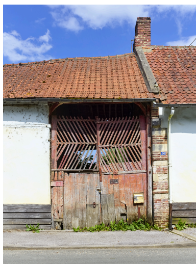
Détail de la porte charretière, depuis l'ouest.
