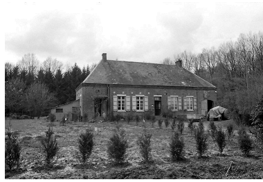
Vue générale. Phot. Xavier-Philippe Guiochon IVR22_19980200824Z
