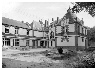
Institution Sangnier, avant la construction de l'aile gauche de l'école, photographie (Archives lasalliennes, Institution Sangnier). Repro. Archives lasalliennes IVR32_20258002370NUCA
