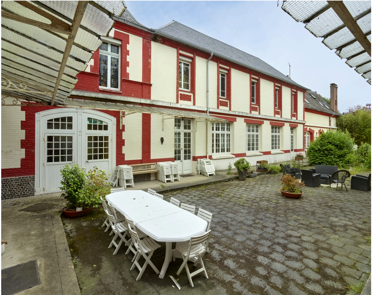
Vue du bâtiment d'école ouest, depuis la cour.
