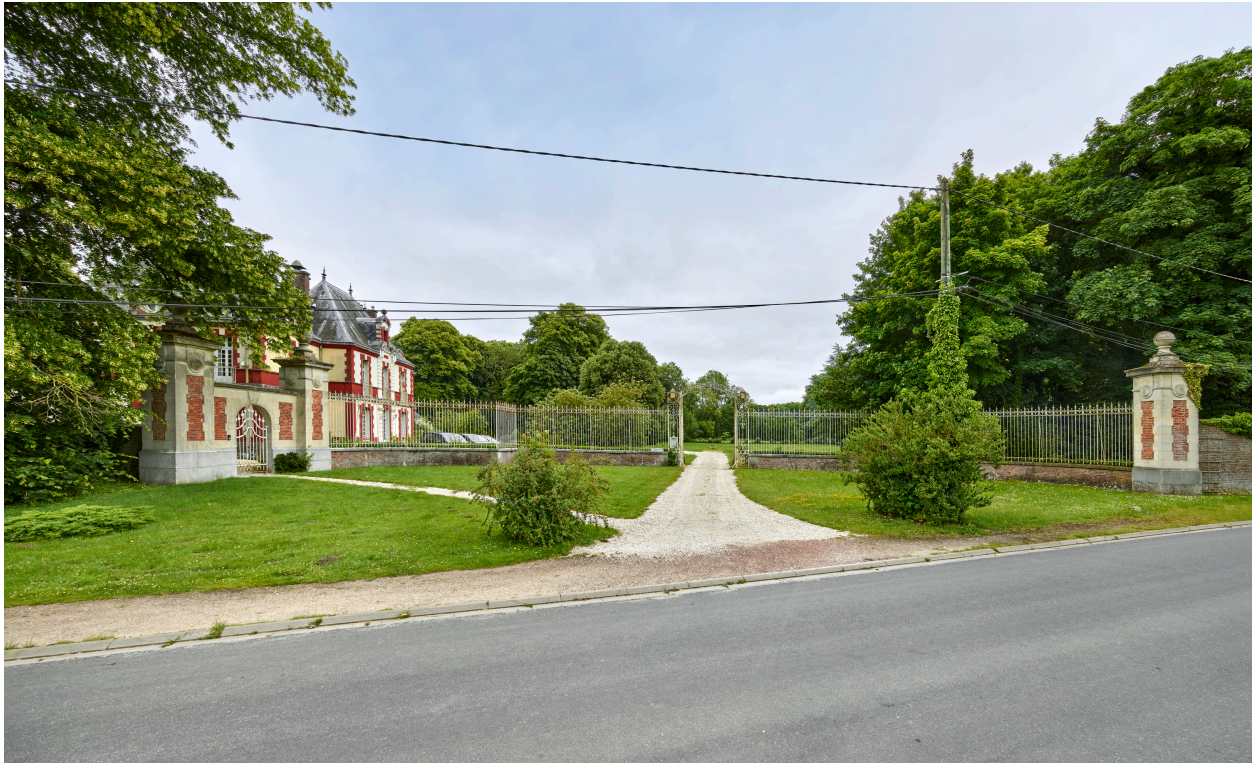
Vue de l'entrée, depuis la rue.
