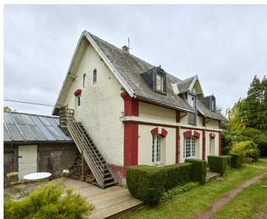
Vue de l'écurie, depuis le sud. Phot. Thierry Lefébure IVR32_20258001546NUCA
