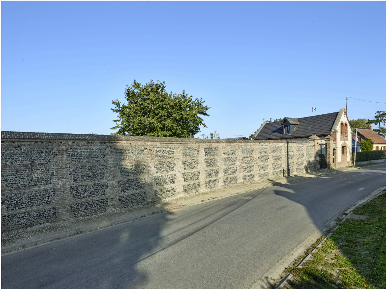
Mur de clôture de l'ancien jardin potager, face au château.
