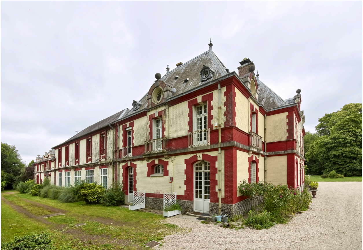
Vue de l'édifice, depuis l'ouest.
