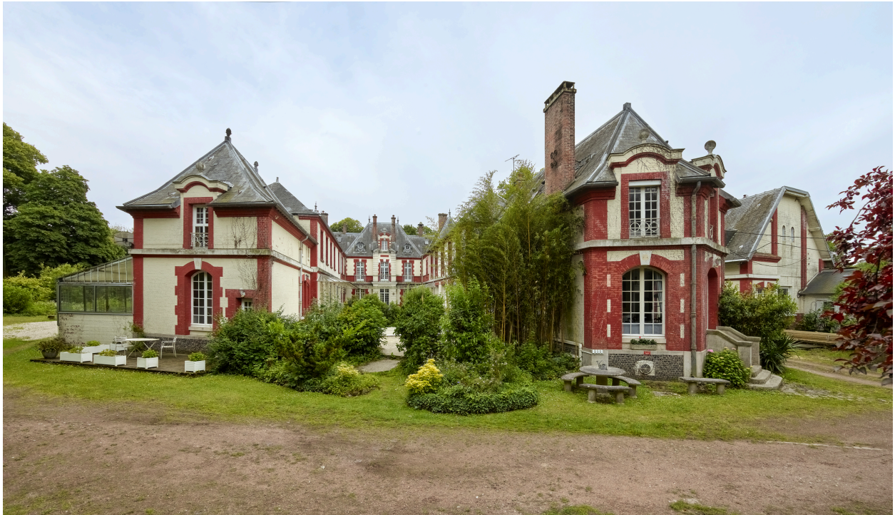
Vue d'ensemble de l'édifice, depuis le nord.
