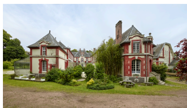
Vue d'ensemble de l'édifice, depuis le nord. Phot. Thierry Lefébure
