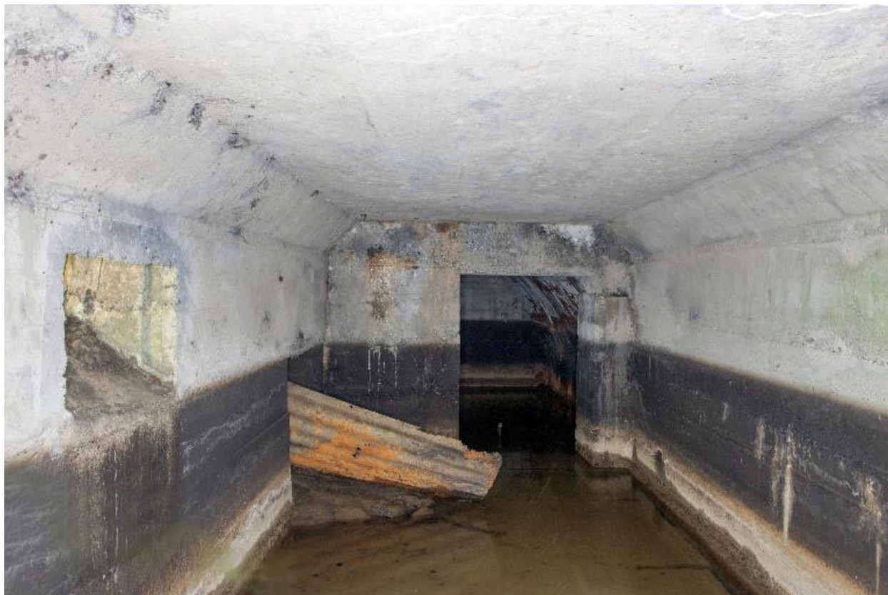
Vue interieure, vers l'ouest
