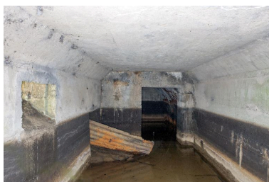
Vue intérieure, vers l'ouest Phot. Pierre Thibaut IVR31_20155901681NUCA
