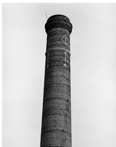
Atelier de fabrication, détail de la cheminée. Phot. Olivier Marlard IVR31_19885902192X
