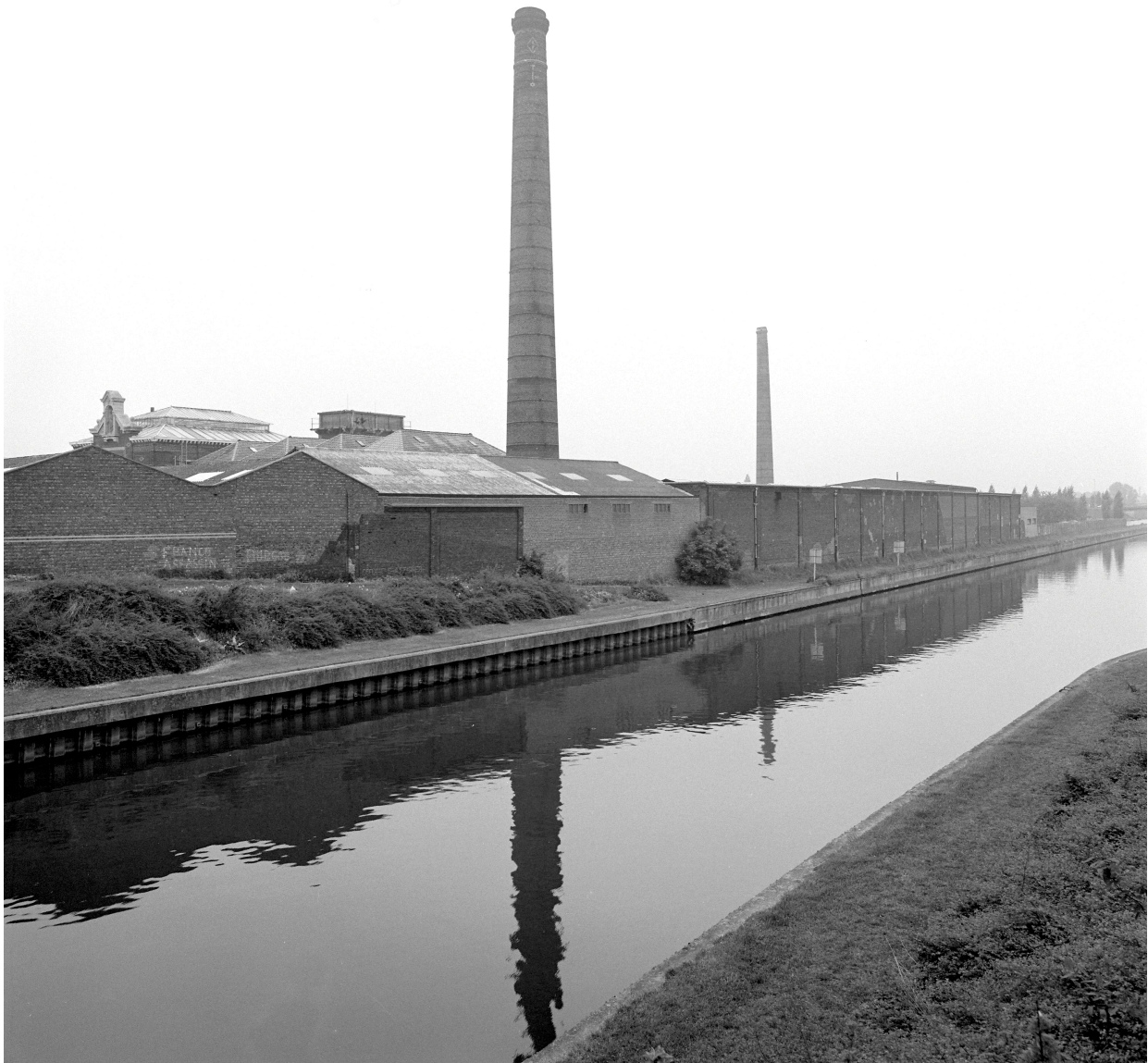
Vue générale vers l'est.
