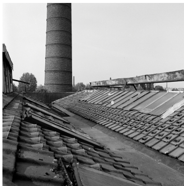
Atelier de fabrication, vue des toits. Phot. Philippe Dapvril IVR31_19885900765X
