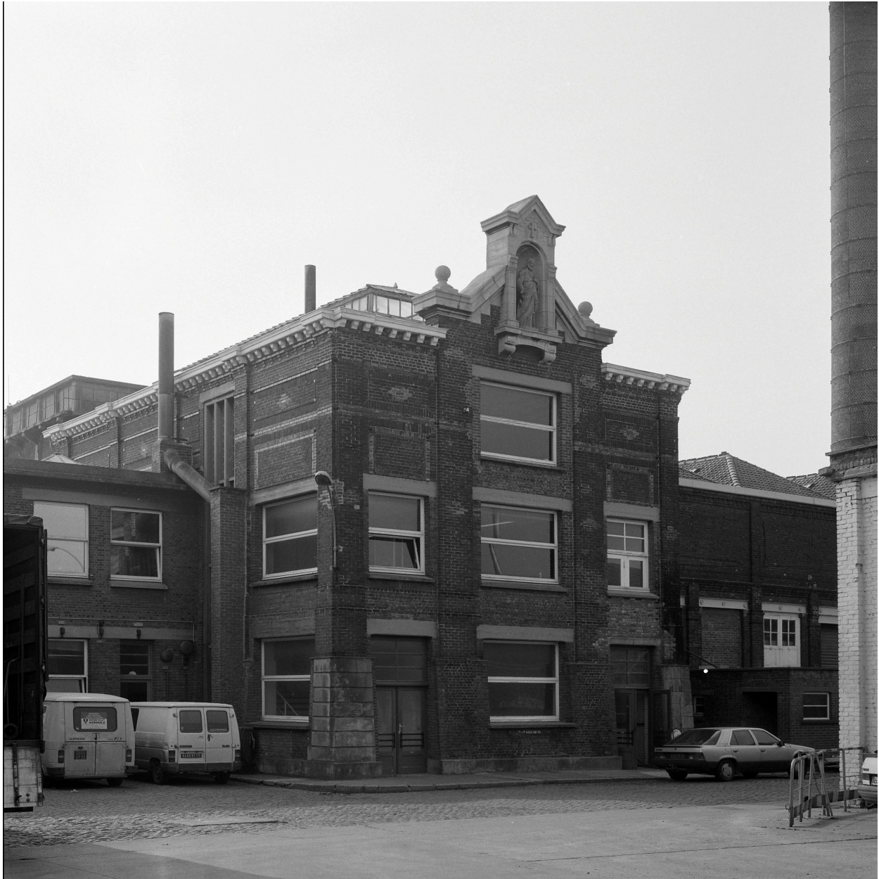
Salle des machines, vue extérieure.
