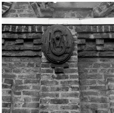
Atelier de fabrication, fer d'ancrage au monogramme MC. Phot. Philippe Dapvril IVR31_19885900762X
