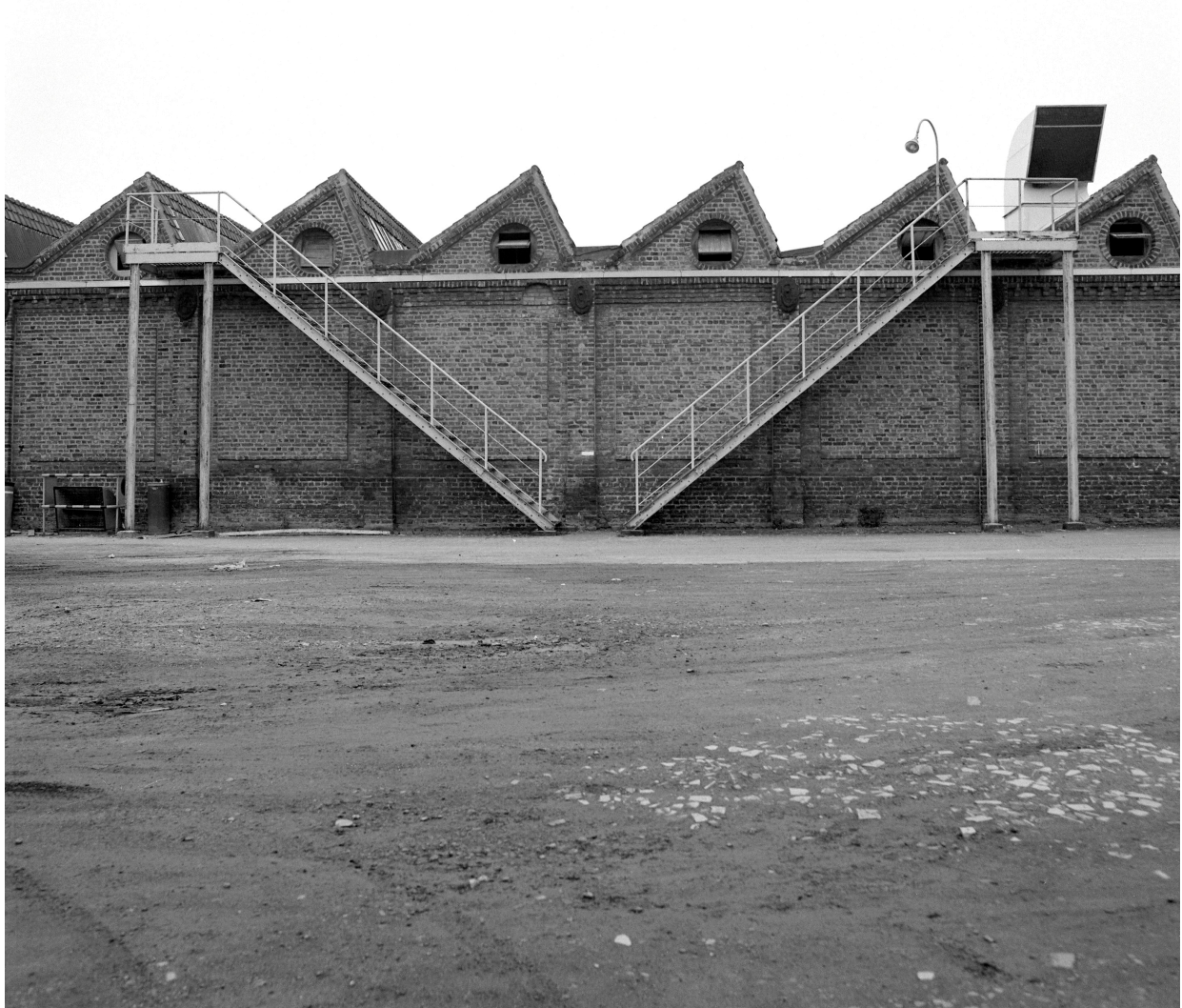
Atelier de fabrication, façade sur cour.
