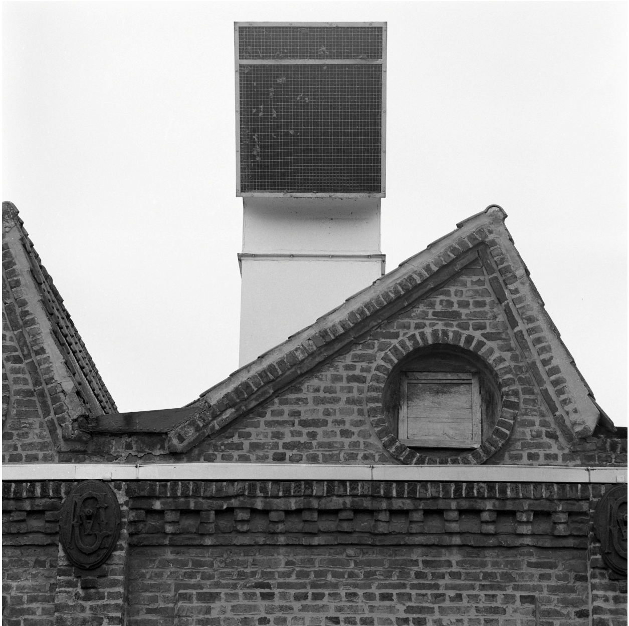
Atelier de fabrication, oculus sur pignon, fer d'ancrage.
