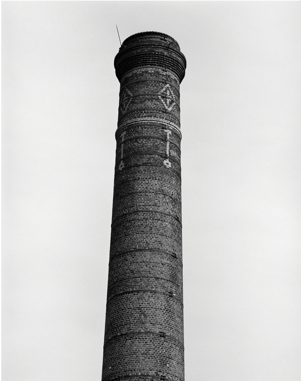
Atelier de fabrication, détail de la cheminée.
