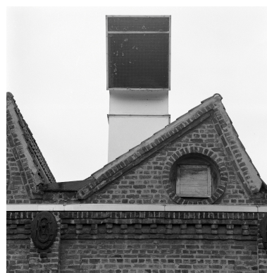
Atelier de fabrication, oculus sur pignon, fer d'ancrage. Phot. Philippe Dapvril IVR31_19885900761X
