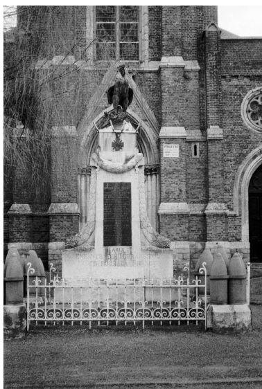
Vue antérieure. Phot. Judith Förstel IVR22_19968000179Z
