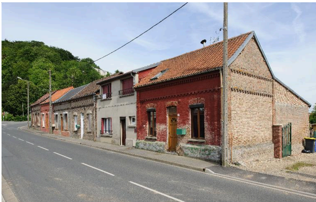
Vue d'ensemble sur rue.
