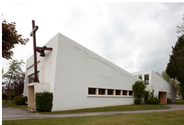
Vue latérale. Phot. Hubert Bouvet IVR31_20106200744NUCA
