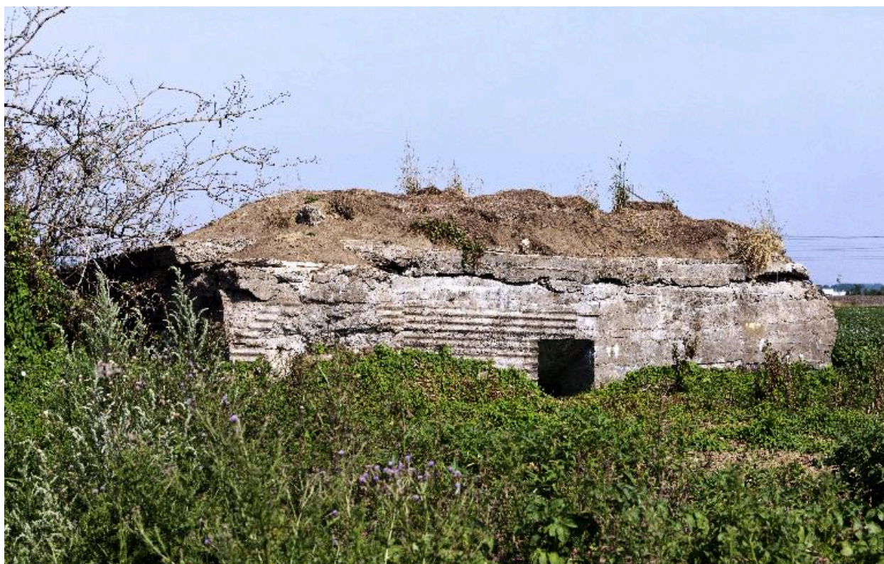
Vue de trois-quarts vers nord
