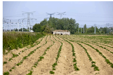
vue générale, vers le nord-ouest Phot. Jean-Marc Ramette IVR31_20145904460NUCA
