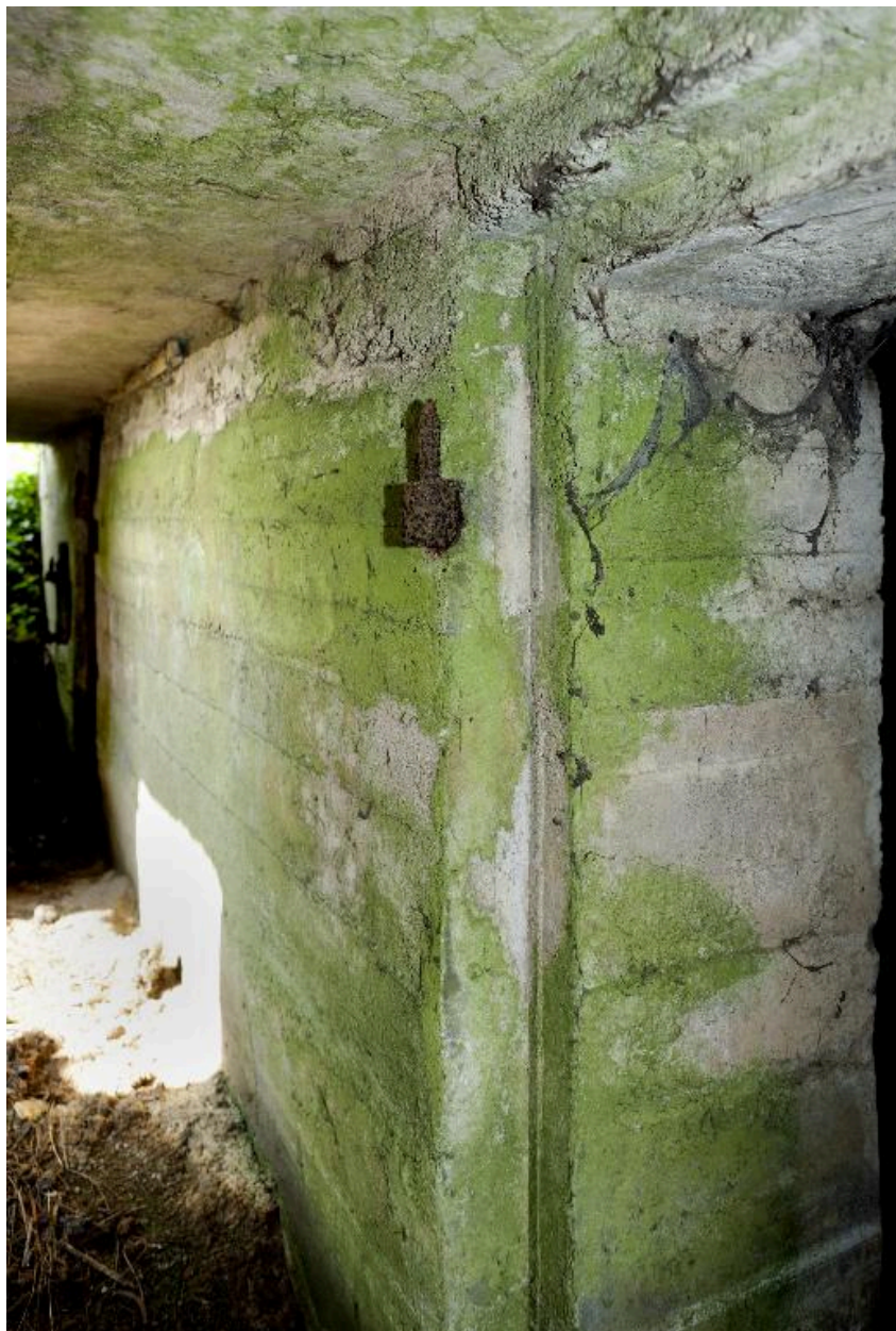
Depuis le couloir de distribution, entrée de la salle nord
