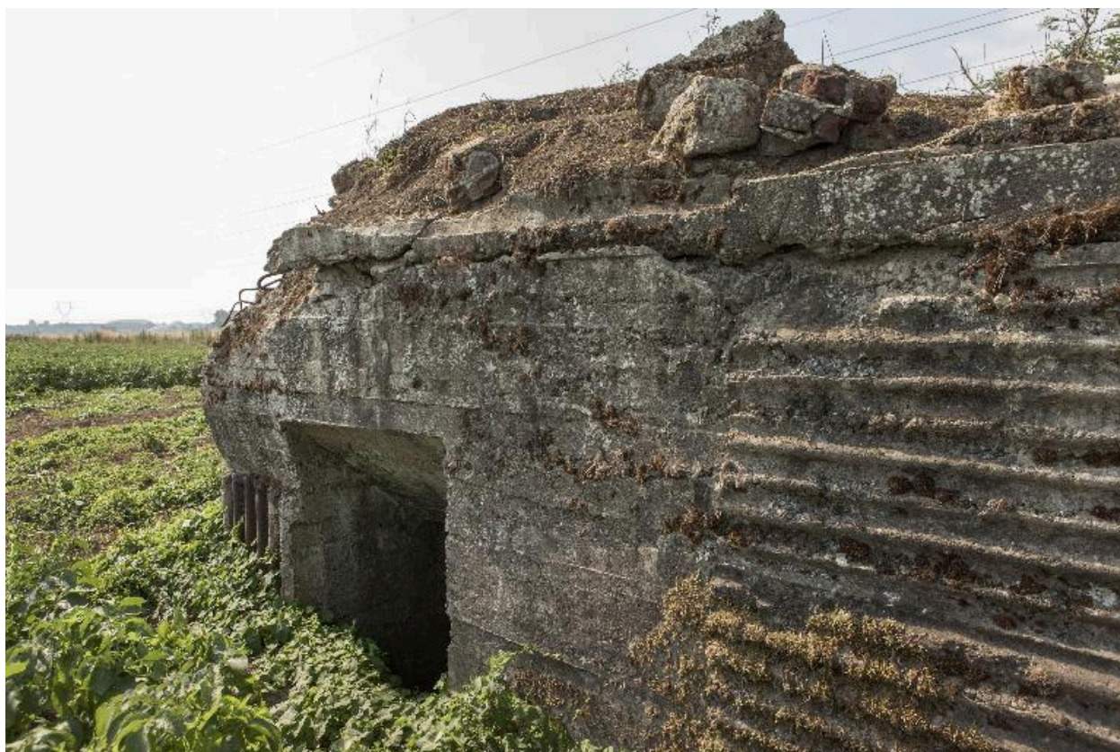
Accès nord du couloir de distribution
