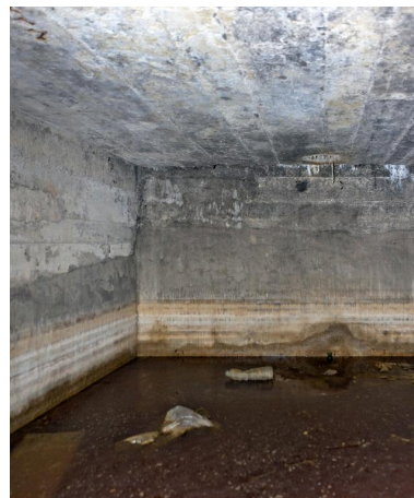
Une des deux salles de l'édifice Phot. Jean-Marc Ramette IVR31_20145904468NUCA
