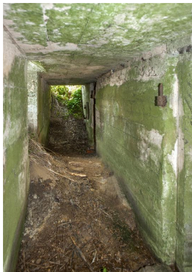
Couloir de distribution, vers le sud Phot. Jean-Marc Ramette IVR31_20145904467NUCA
