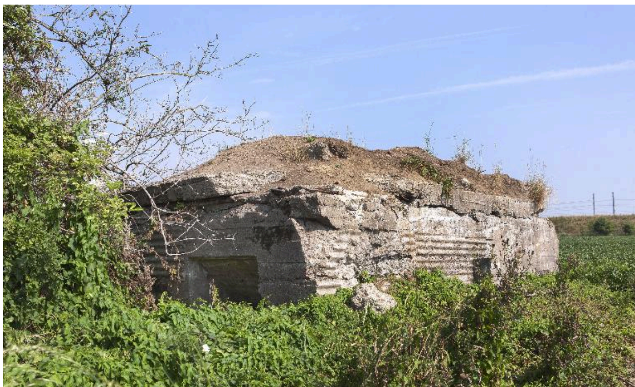
Vue de trois-quarts vers nord
