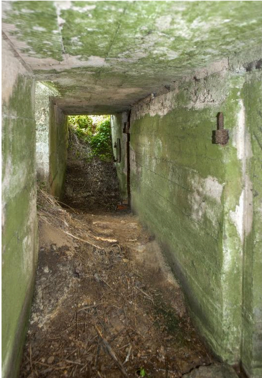
Couloir de distribution, vers le sud
