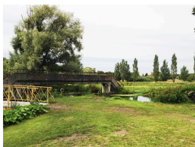
Vue vers les marais. Phot. Isabelle Barbedor IVR22_20158006259NUCA
