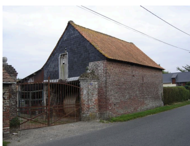
Vue de la charreterie sur rue. Phot. Inès Guérin IVR22_20068005076NUCA
