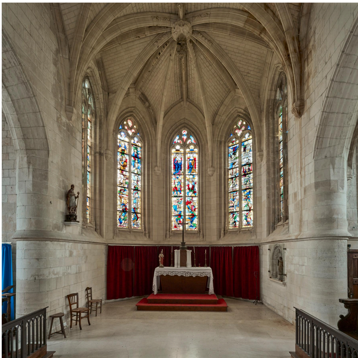
Le chœur de l'église et ses verrières.
